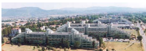
Espansione edilizia in periferia
