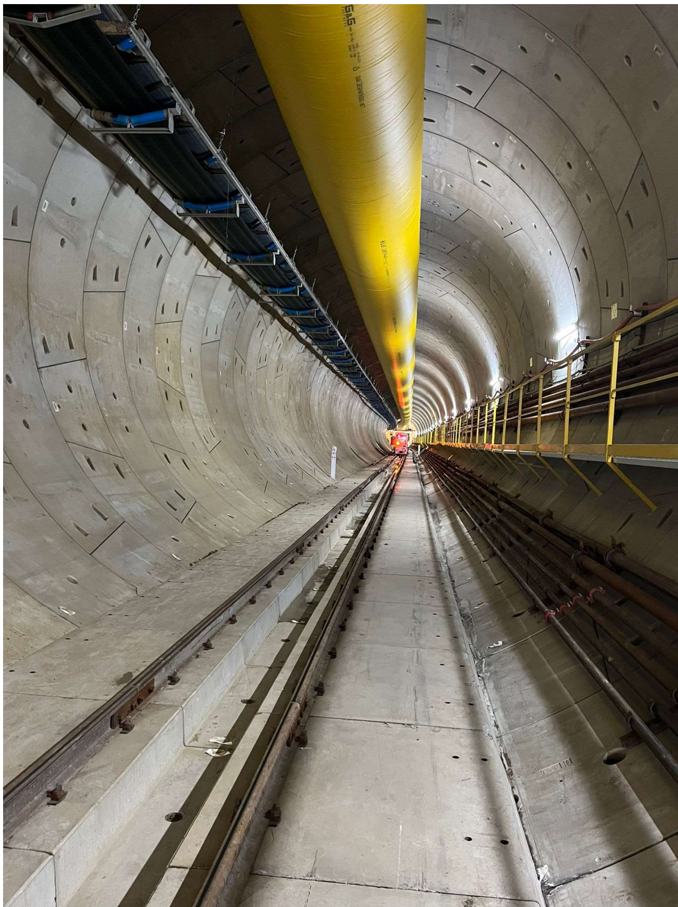
Figura 5 – Scavo Galleria Binario Pari
