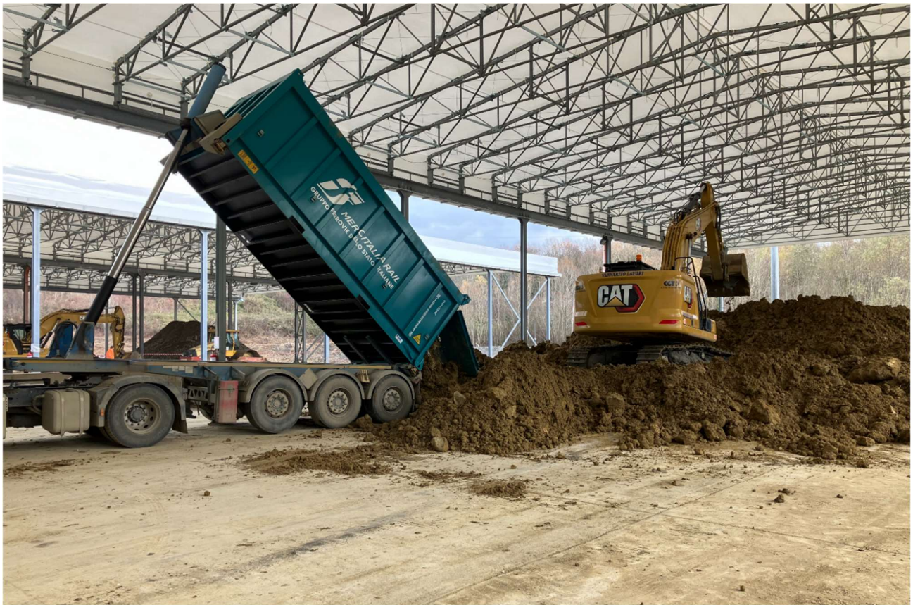
Figura 7 – Scarico terre in piazzola (Santa Barbara)
