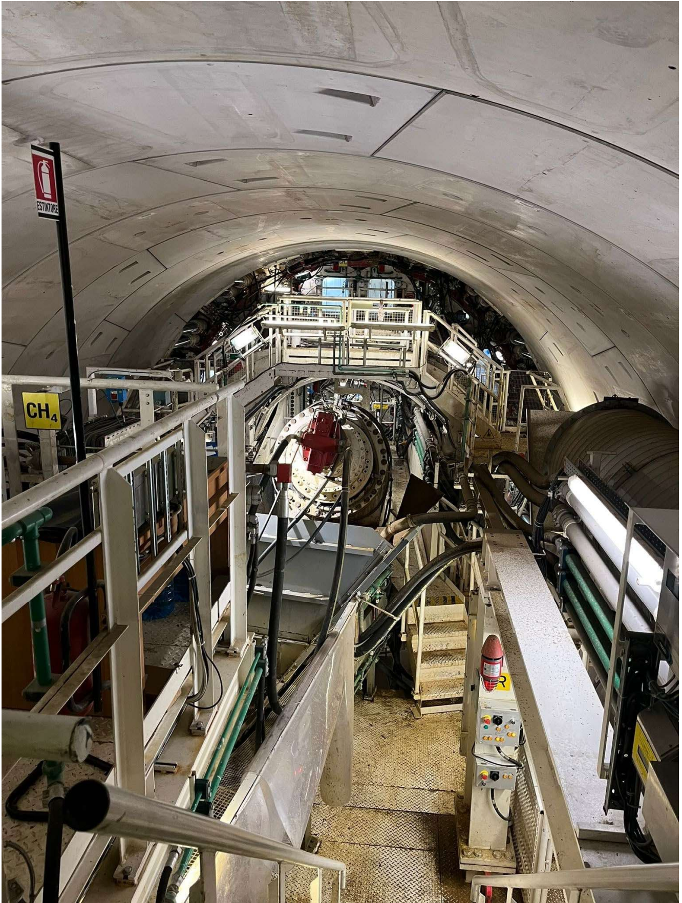
Figura 4 – Scavo Galleria Binario Pari
