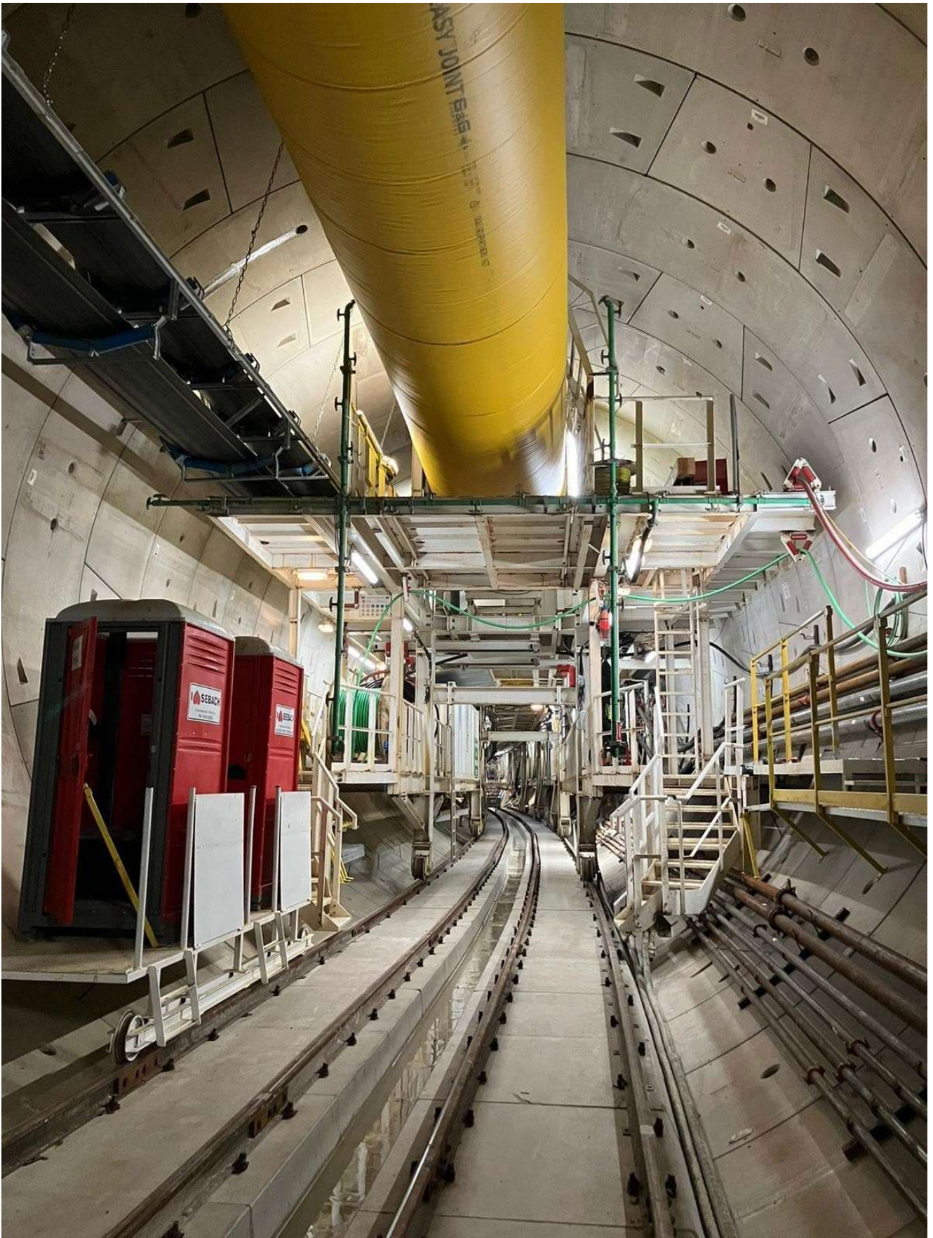
Figura 5 – Scavo Galleria Binario Pari
