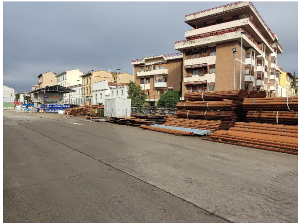
Area di cantiere
