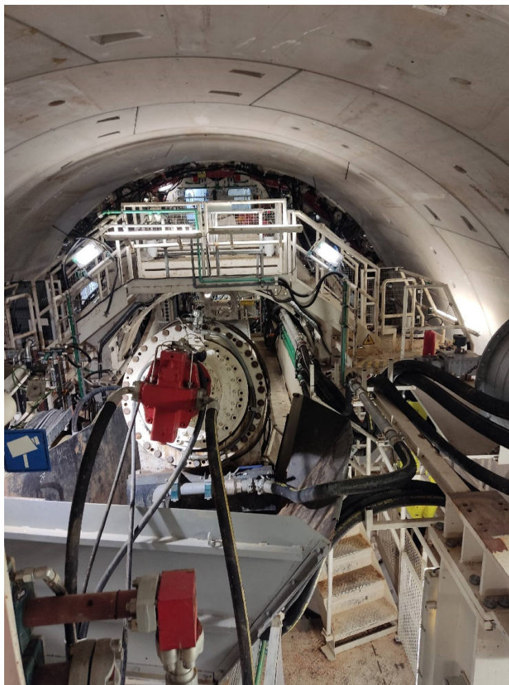
Vista posteriore della TBM
