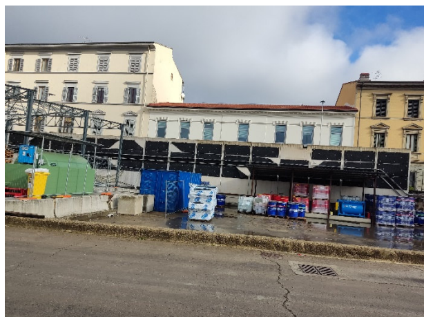
Pareti con pannellature fonoassorbenti
