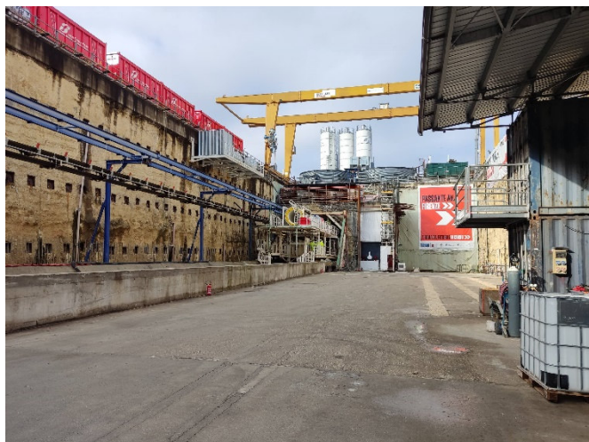
Area di inizio scavo
