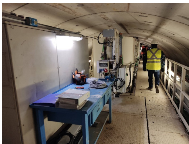
Percorso interno della TBM
