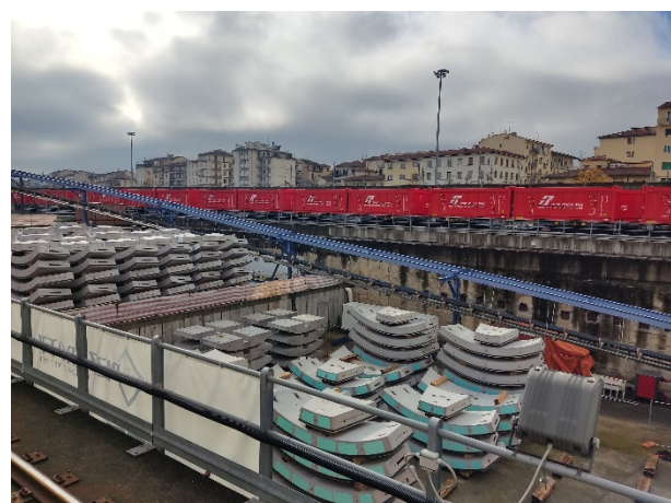
Area stoccaggio conci per la realizzazione degli anelli
