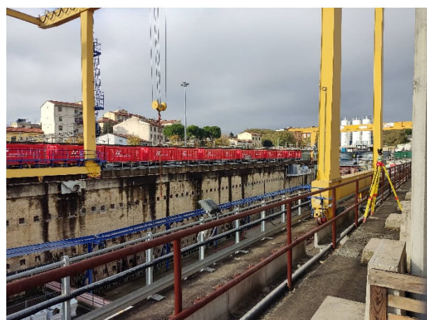
Area di cantiere dello scavo dall'alto
