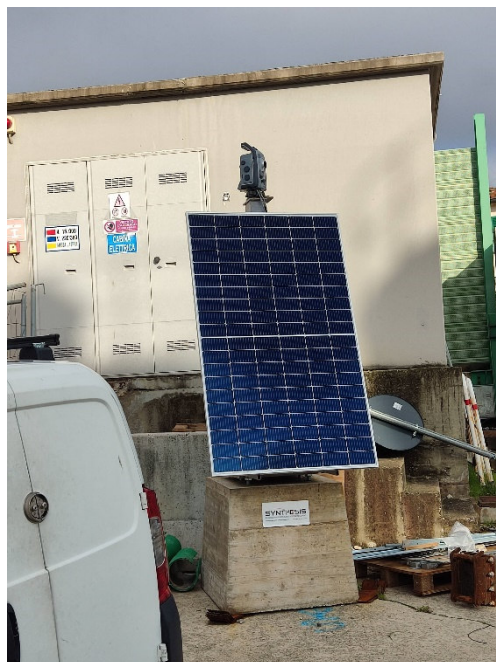
Stazione fissa di monitoraggio
