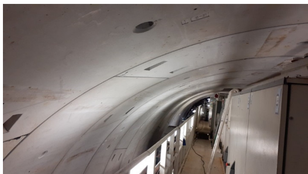
Particolare conci già montati a formare l'anello
