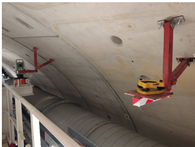
Sistemi di rilevamento lungo lo scavo
