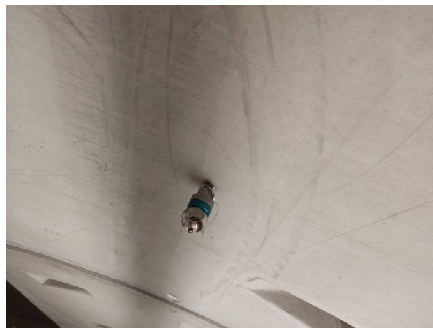
Mire lungo lo scavo
