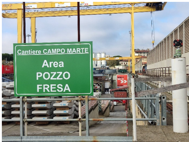
Area di cantiere dello scavo
