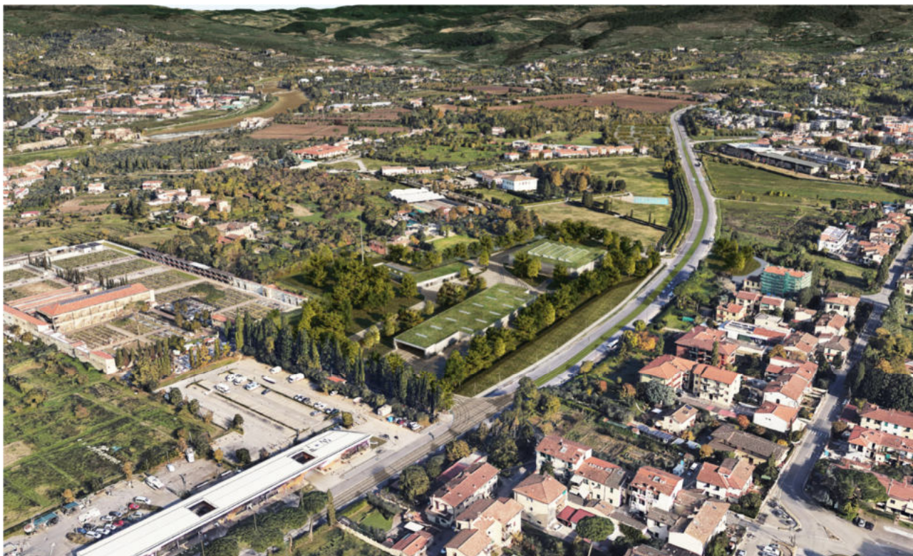
Figura 12: Vista aerea della nuova infrastruttura tranviaria su via Pian di Ripoli e del deposito
