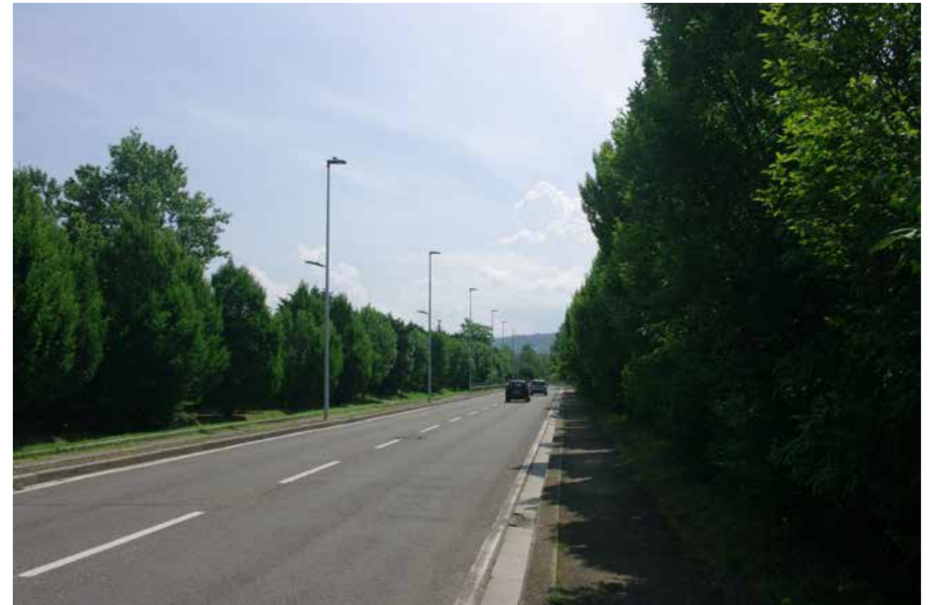
FOTO 44. Via della Chimera, vista verso Stazione Rovezzano (PR 36)
