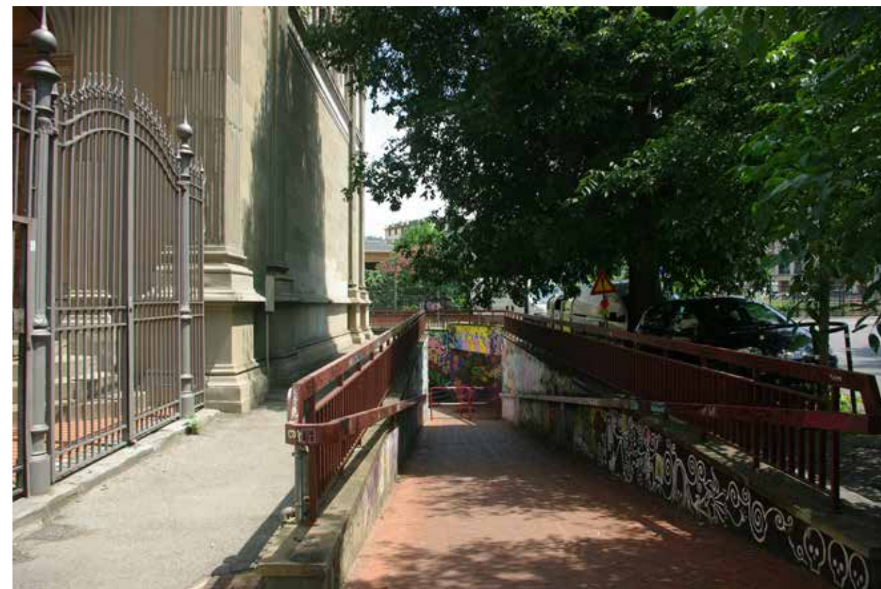
FOTO 7. Viale Don Minzoni, verso Piazza le cure, ingresso sottopassaggio ciclo pedonale (PR 6 )
