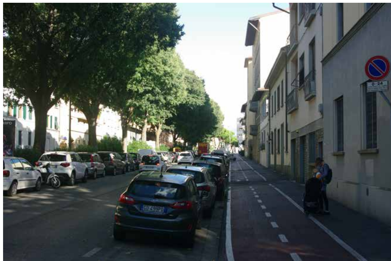
FOTO 24. Viale Mamiani, vista verso viale E. Duse (PR 21)
