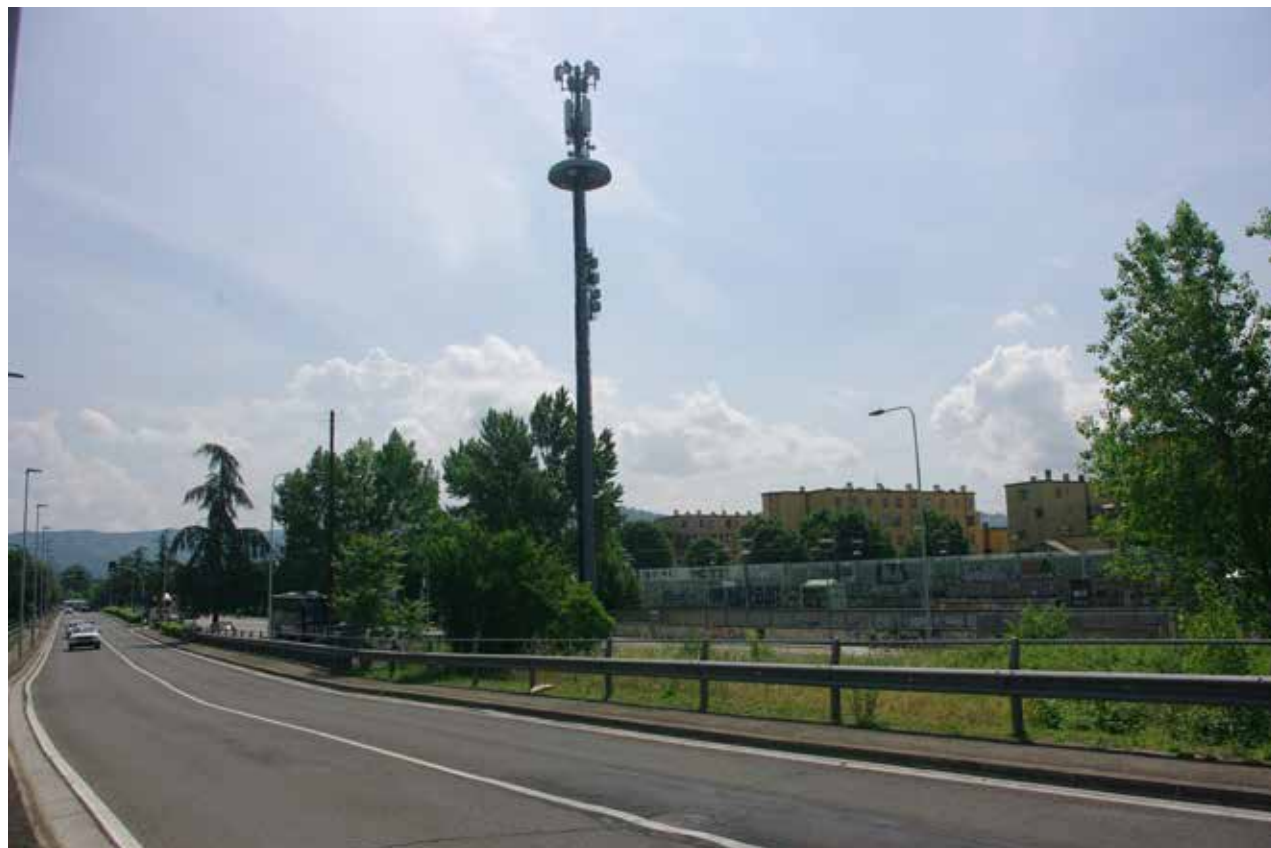
FOTO 46. Via della Chimera, vista verso Stazione Rovezzano (PR 37)
