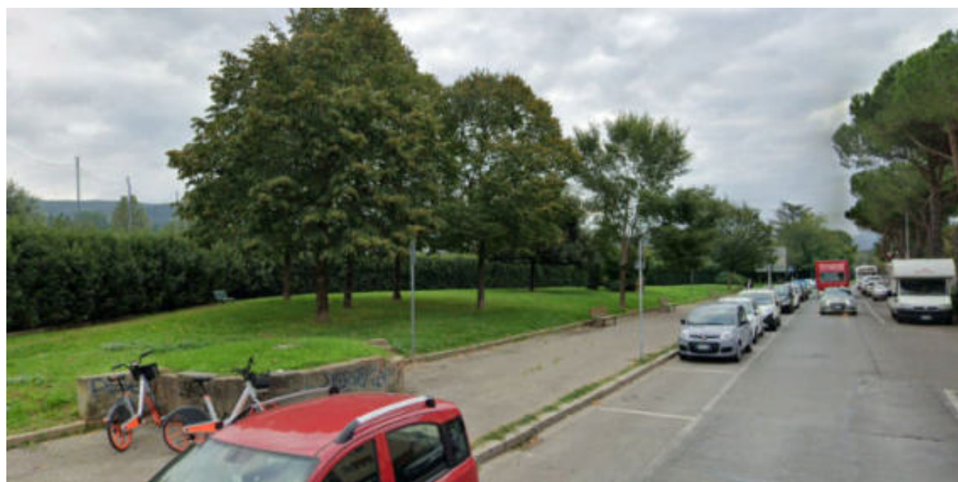
Sotto-stazione elettrica Coverciano: foto dello stato attuale
