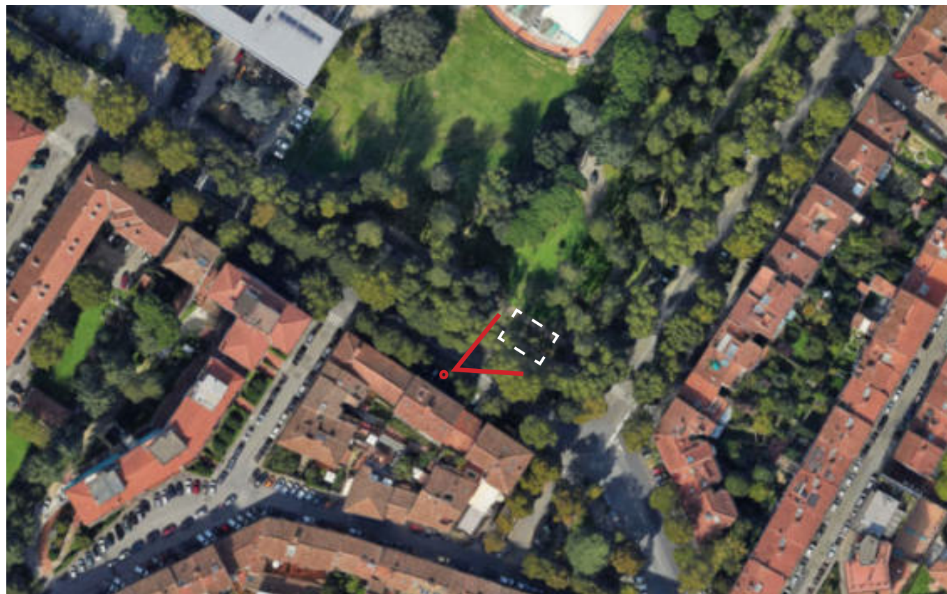
Sottostazione elettrica Piscine in viale Malta: Foto aerea con punto di ripresa fotografica
