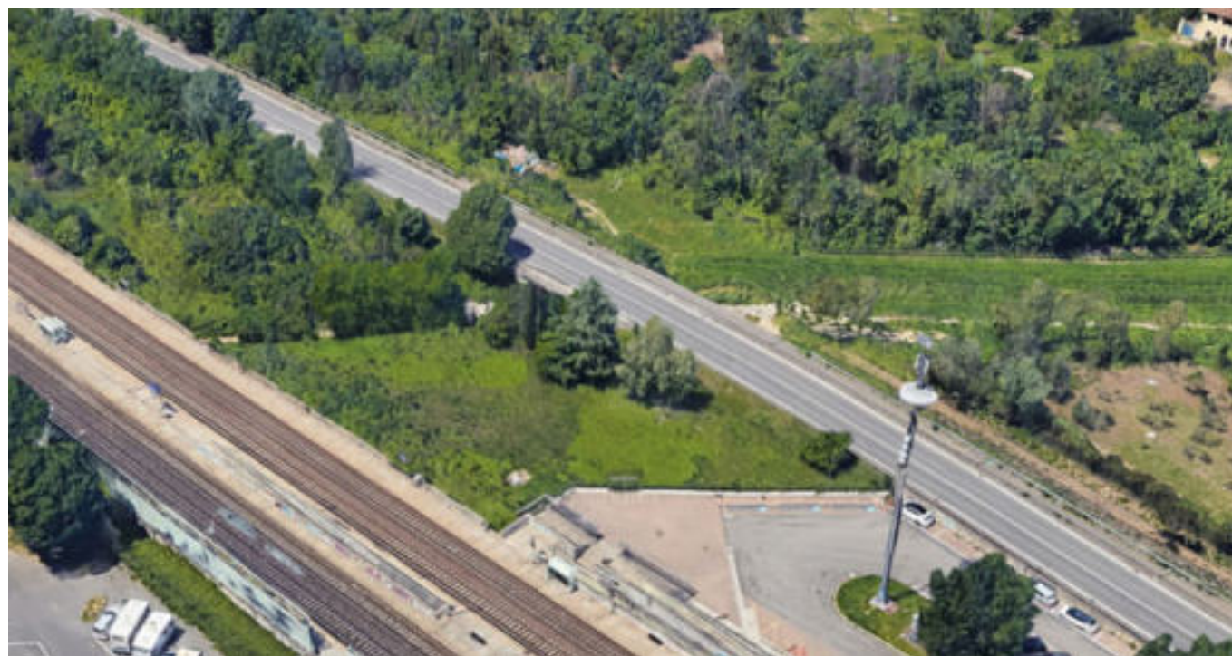
Sotto stazione elettrica Rovezzano: foto dello stato attuale
