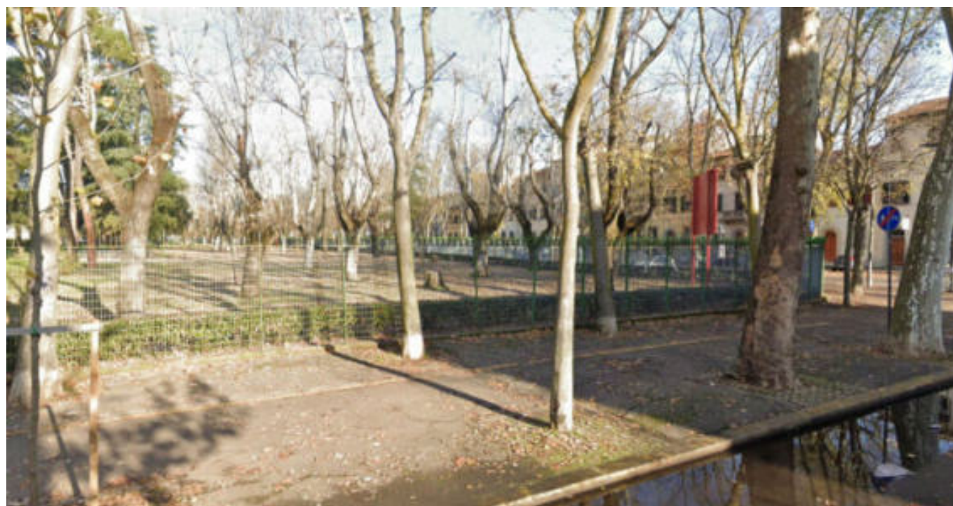
Sottostazione elettrica Piscine in viale Malta, foto dello stato attuale
