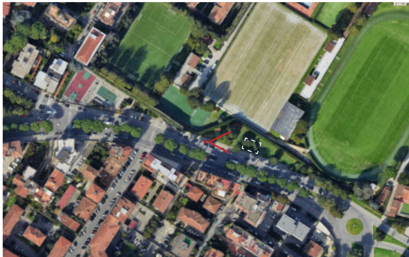
Sotto-stazione elettrica Coverciano: Foto aerea con punto di ripresa fotografica
