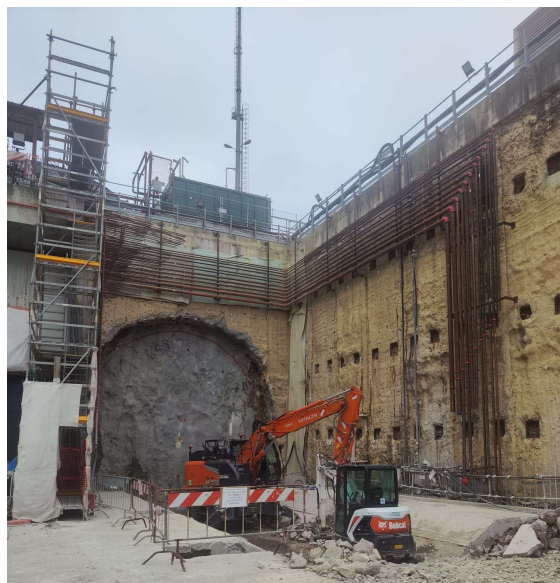
Imbocco della galleria binario dispari
