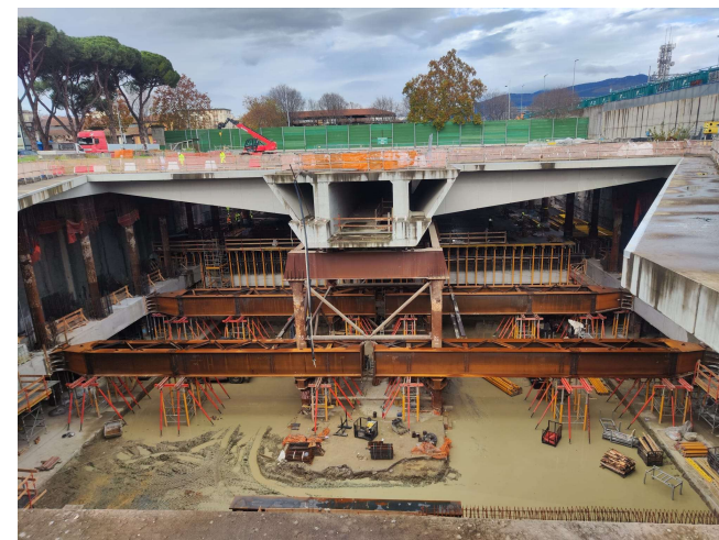
Cantiere della Stazione AV
