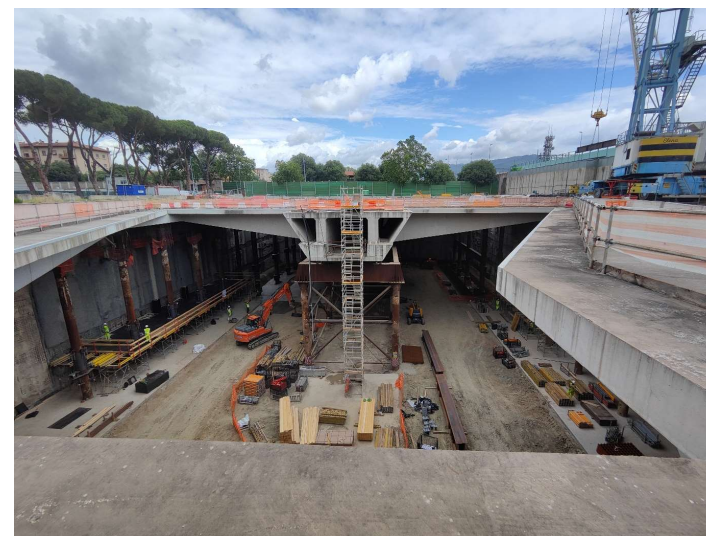
Cantiere della Stazione AV Belfiore
