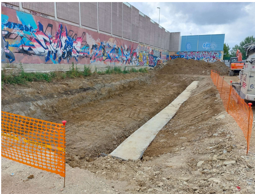
Cantiere scuola Ottone Rosai
