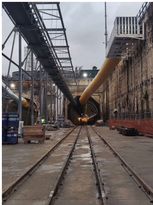
Scavo della galleria Binario Dispari
