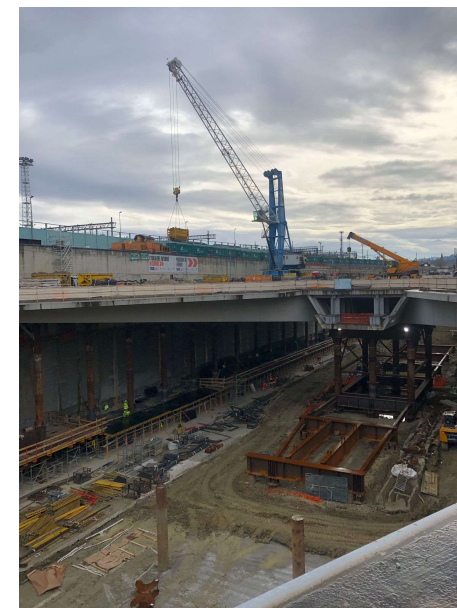
Cantiere della Stazione AV
