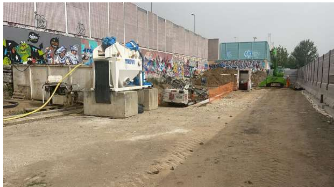
Cantiere scuola Ottone Rosai
