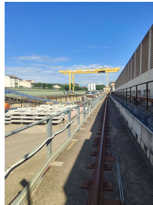
Percorso verso il pozzo lancio frese
