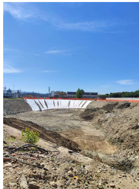
By-pass torrente Mugnone Attività in corso
