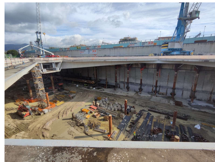
Cantiere della Stazione AV
