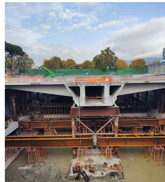
Cantiere della Stazione AV
