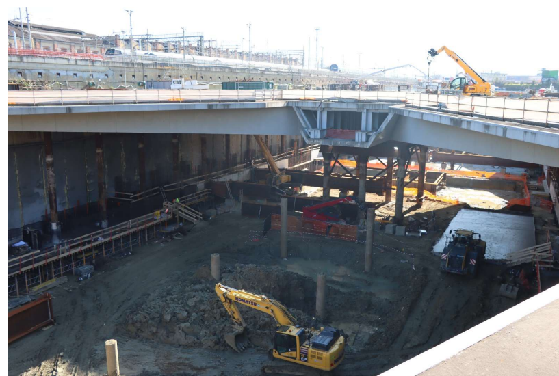
Cantiere della Stazione AV
