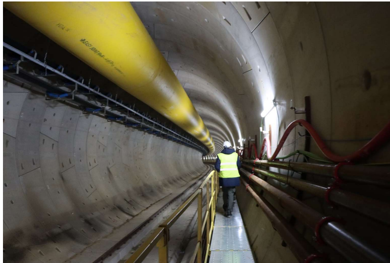
Scavo della galleria Binario Dispari
