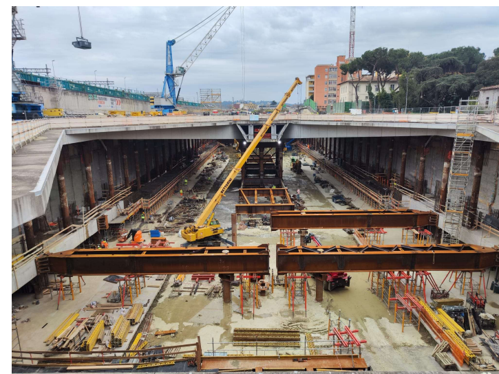
Cantiere della Stazione AV
