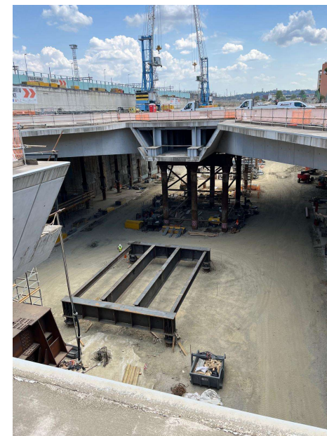
Cantiere della Stazione AV
