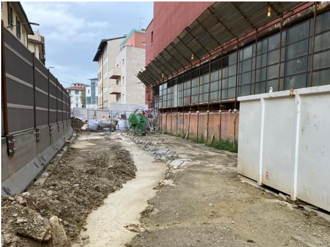
Figura 16 - Via delle Ghiacciaie (Edificio 29)
