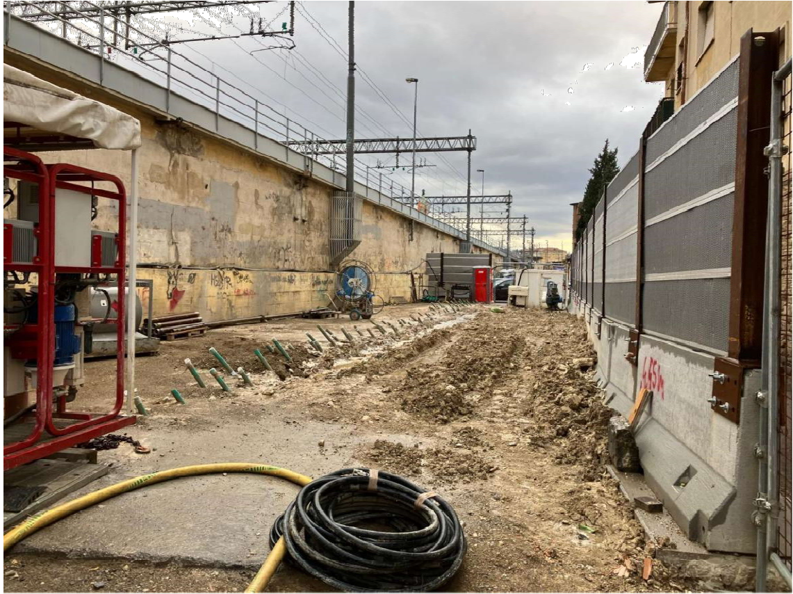
Figura 15 – Via delle Ghiacciaie (Edificio 35)
