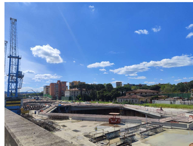
Cantiere della Stazione AV
