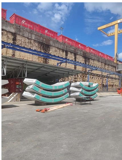
Conci pronti per essere installati
