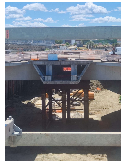
Cantiere della Stazione AV
