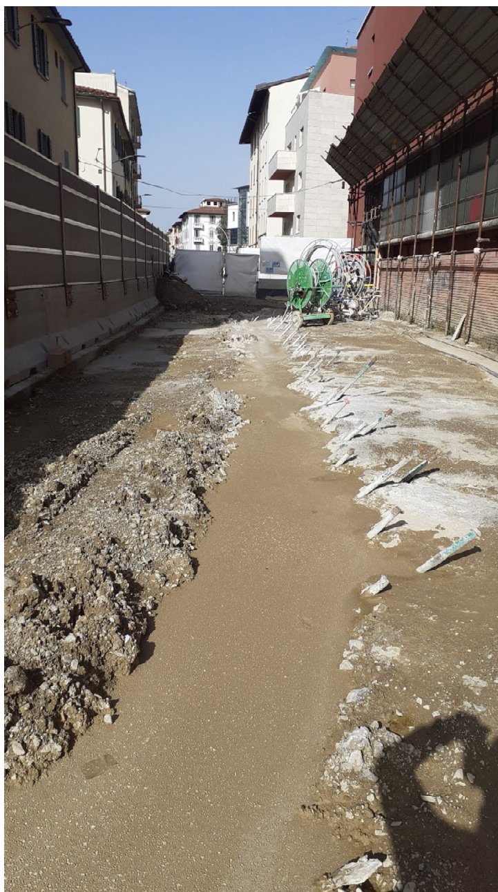
Area di iniezione edificio 29
