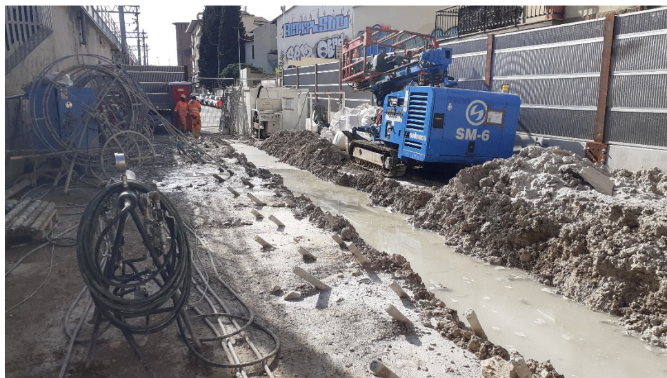
Area di iniezione edificio 35
