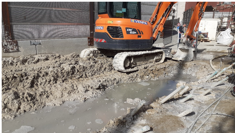
Area di iniezione edificio 35
