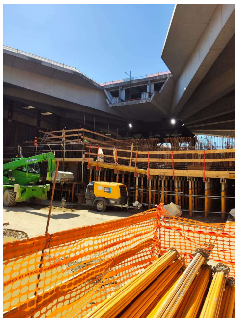
Cantiere della Stazione AV
