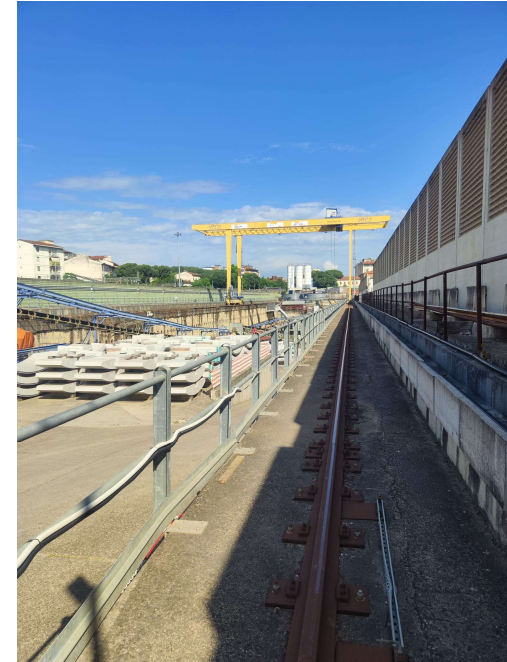
Percorso verso il pozzo lancio frese
