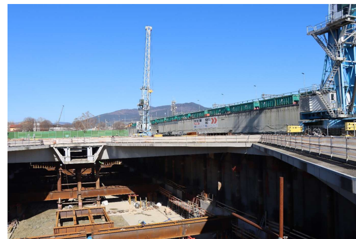
Cantiere della Stazione AV
