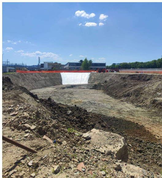
By-pass torrente Mugnone Attività in corso
