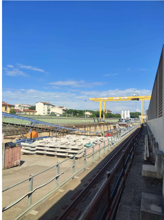
Cantiere di Campo di Marte
