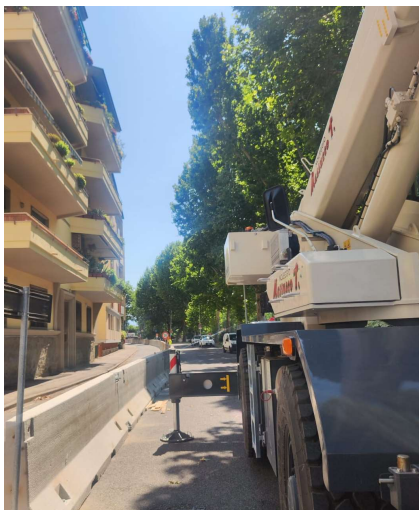
By-pass torrente Mugnone Avvio lavorazioni in via Cosseria
