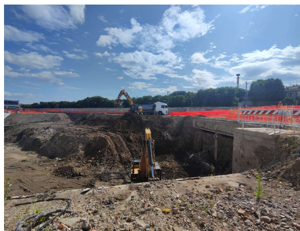
By-pass torrente Mugnone Lato viale Redi
