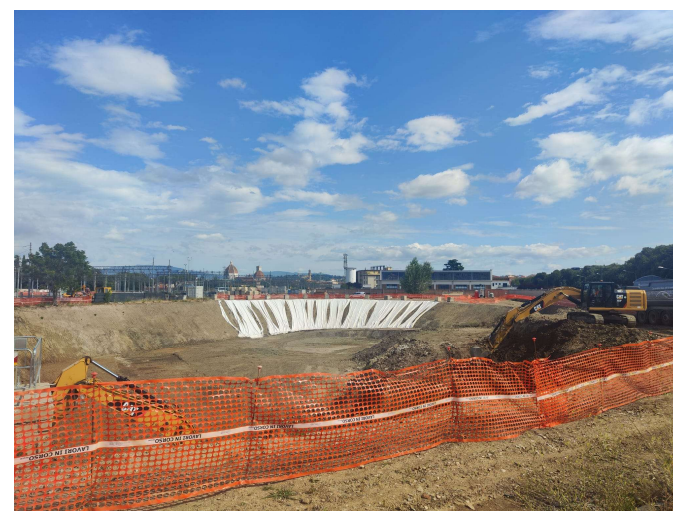
By-pass torrente Mugnone Attività in corso
