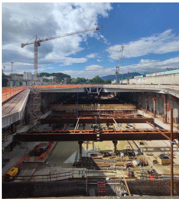
Cantiere della Stazione AV
