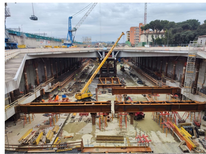
Cantiere della Stazione AV
