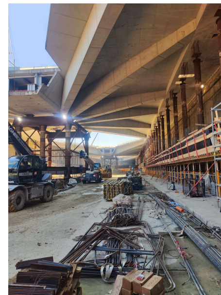
Cantiere della Stazione AV
