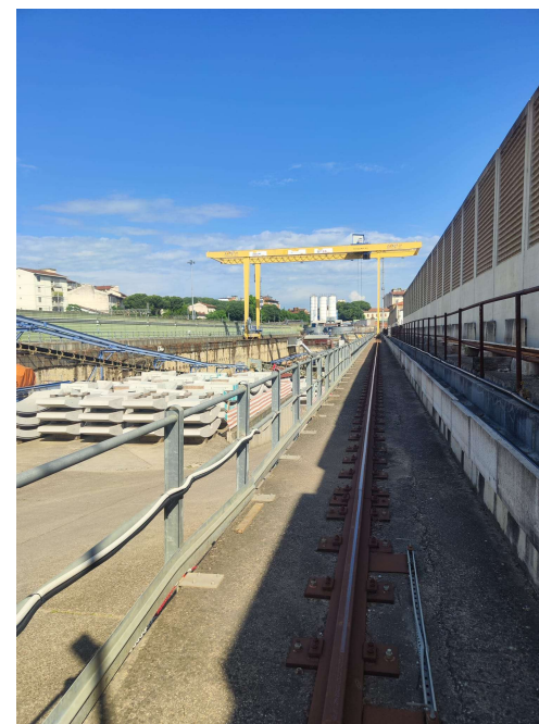
Percorso verso il pozzo lancio frese
