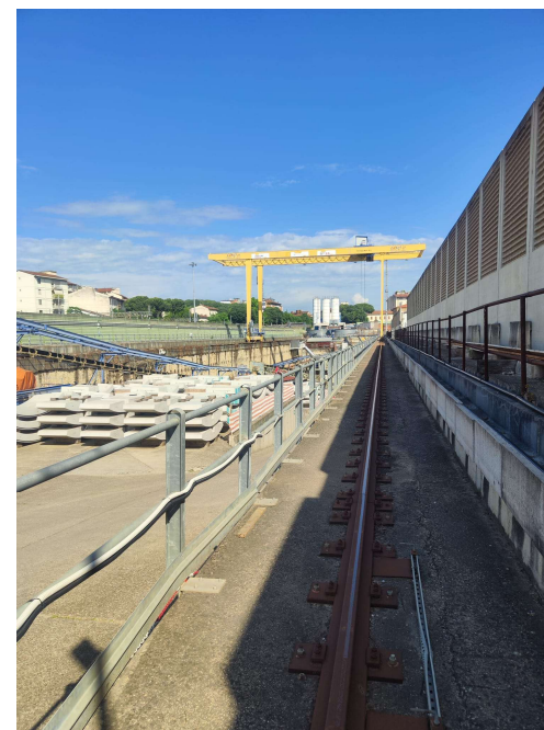
Percorso verso il pozzo lancio frese
