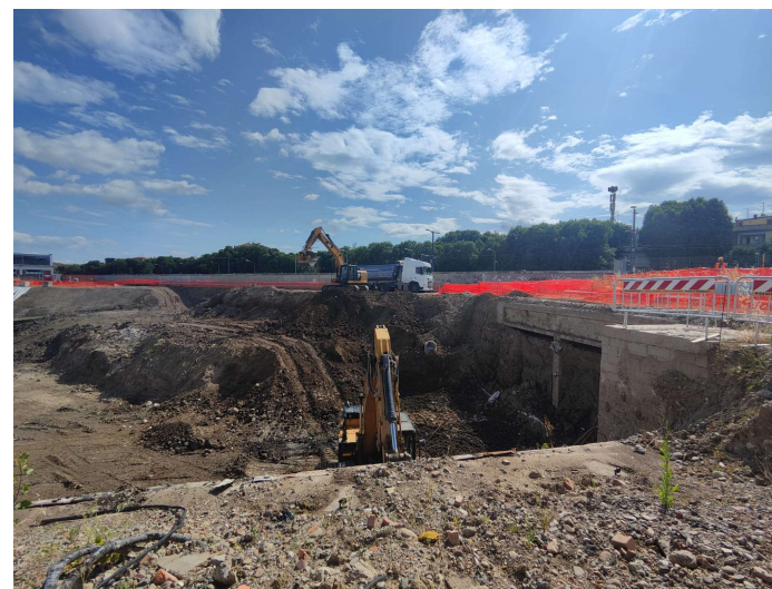
By-pass torrente Mugnone Attività in corso
