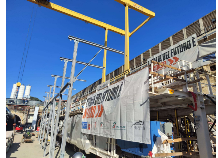
Pozzo di lancio frese – Seconda TBM
