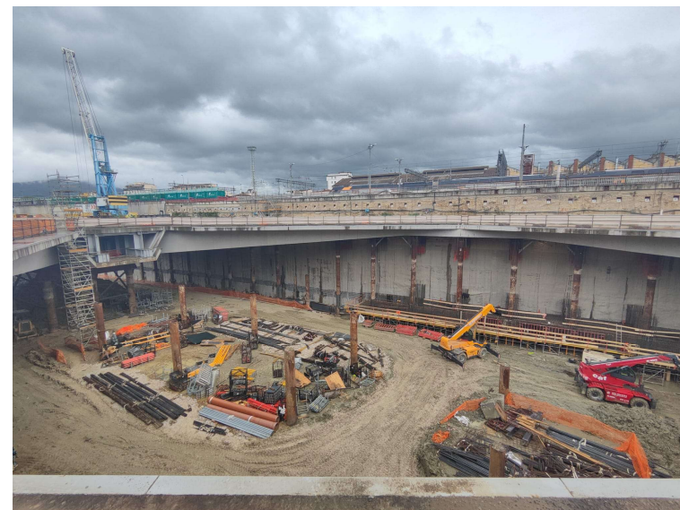
Cantiere della Stazione AV
