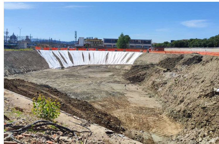
By-pass torrente Mugnone Attività in corso
