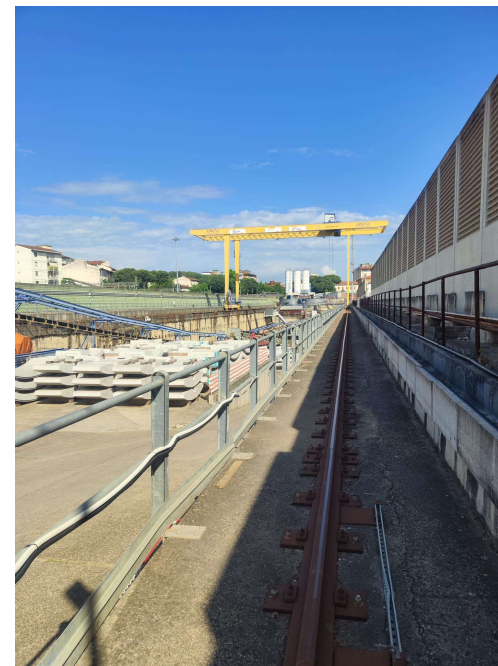
Percorso verso il pozzo lancio frese
