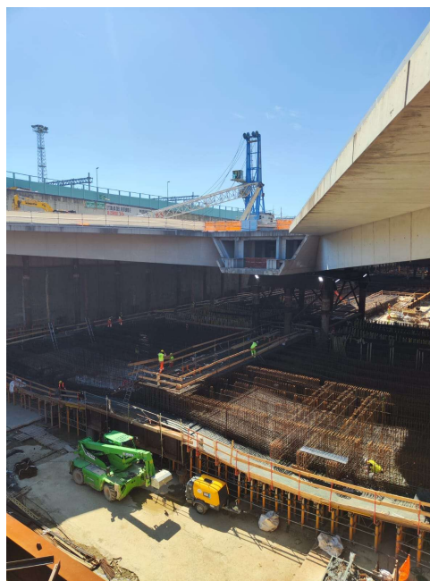
Cantiere della Stazione AV
