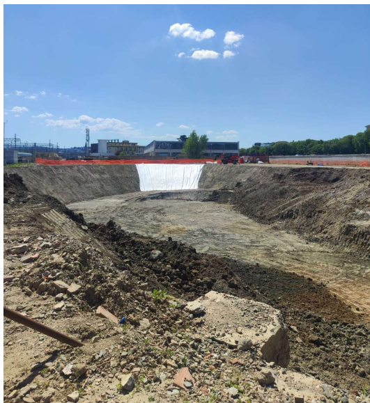
By-pass torrente Mugnone Attività in corso
