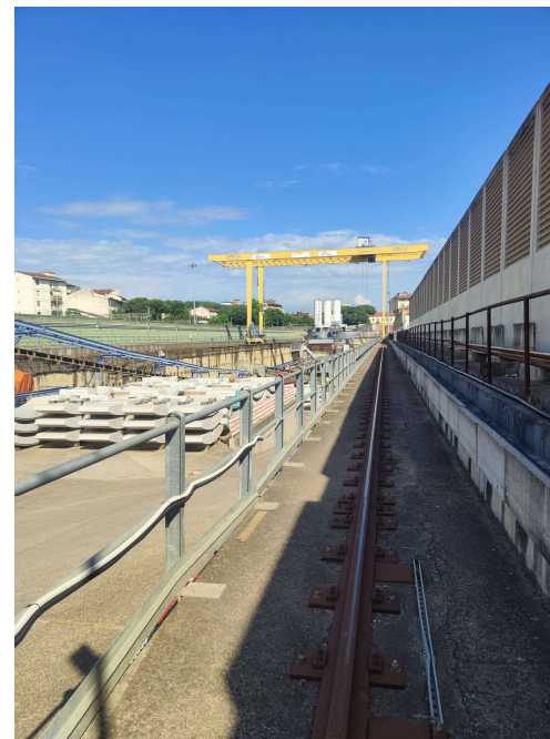
Percorso verso il pozzo lancio frese
