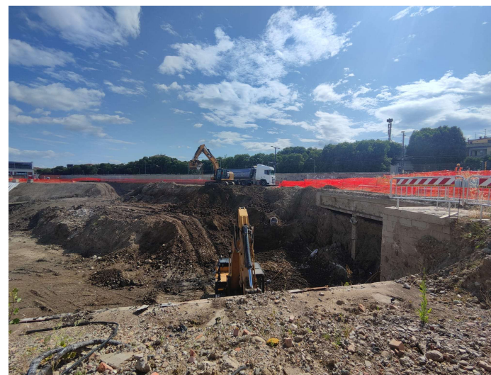
By-pass torrente Mugnone Attività in corso
