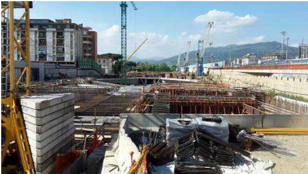
Foto 14 – Panoramica da Sud
