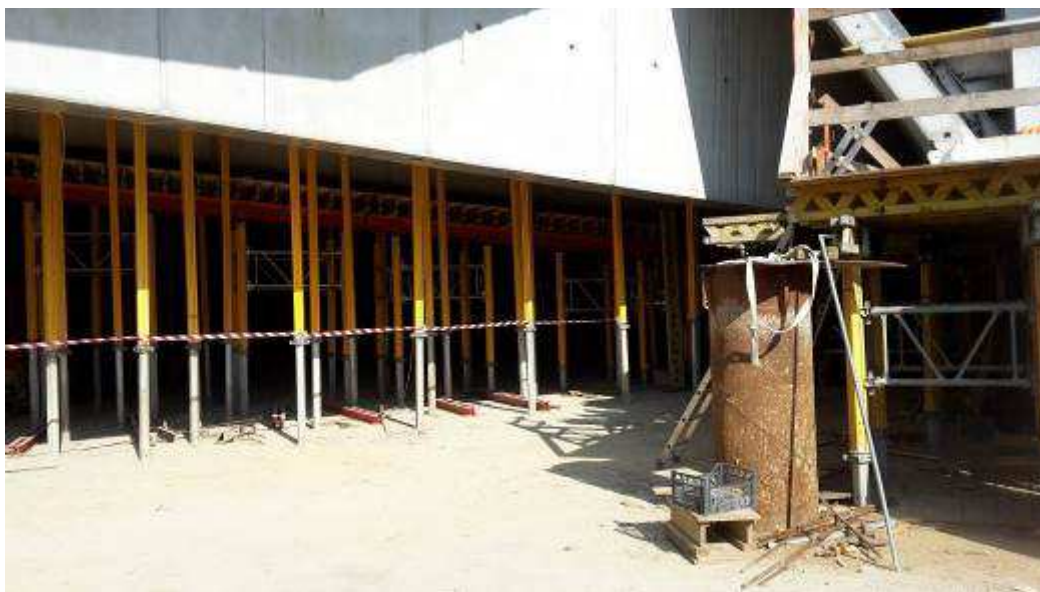
Foto 1 – Rimozione Puntelli e Banchinaggi, Ventaglio Asse 9
