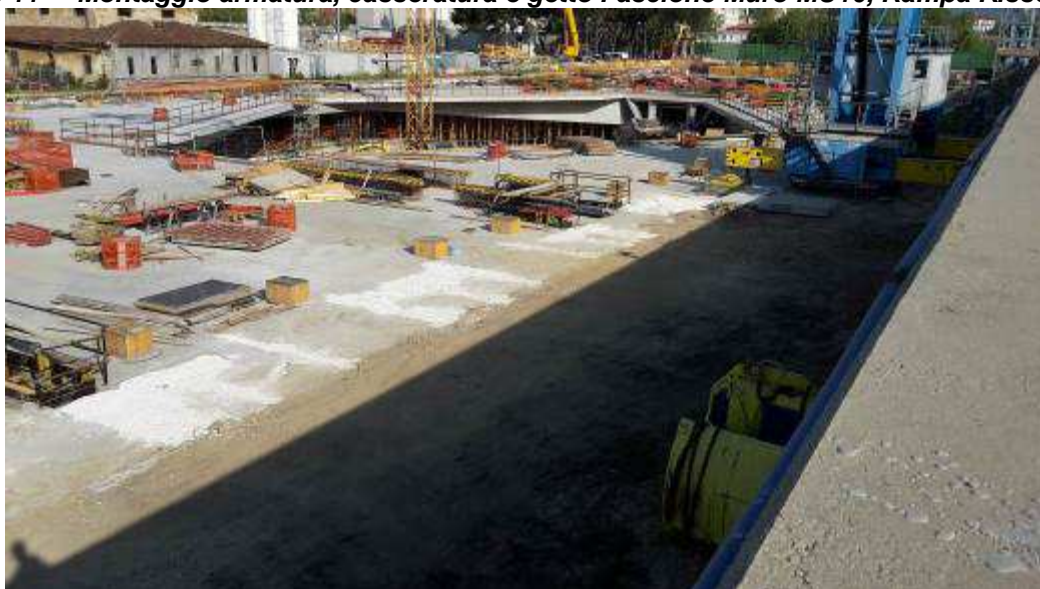
Foto 12 – Rientro a monte diaframmi camerone lato Est
