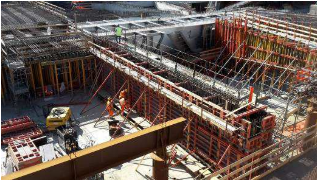
Foto 8 – Montaggio casseri Trave TPT01 Testata Sud - lato Est
