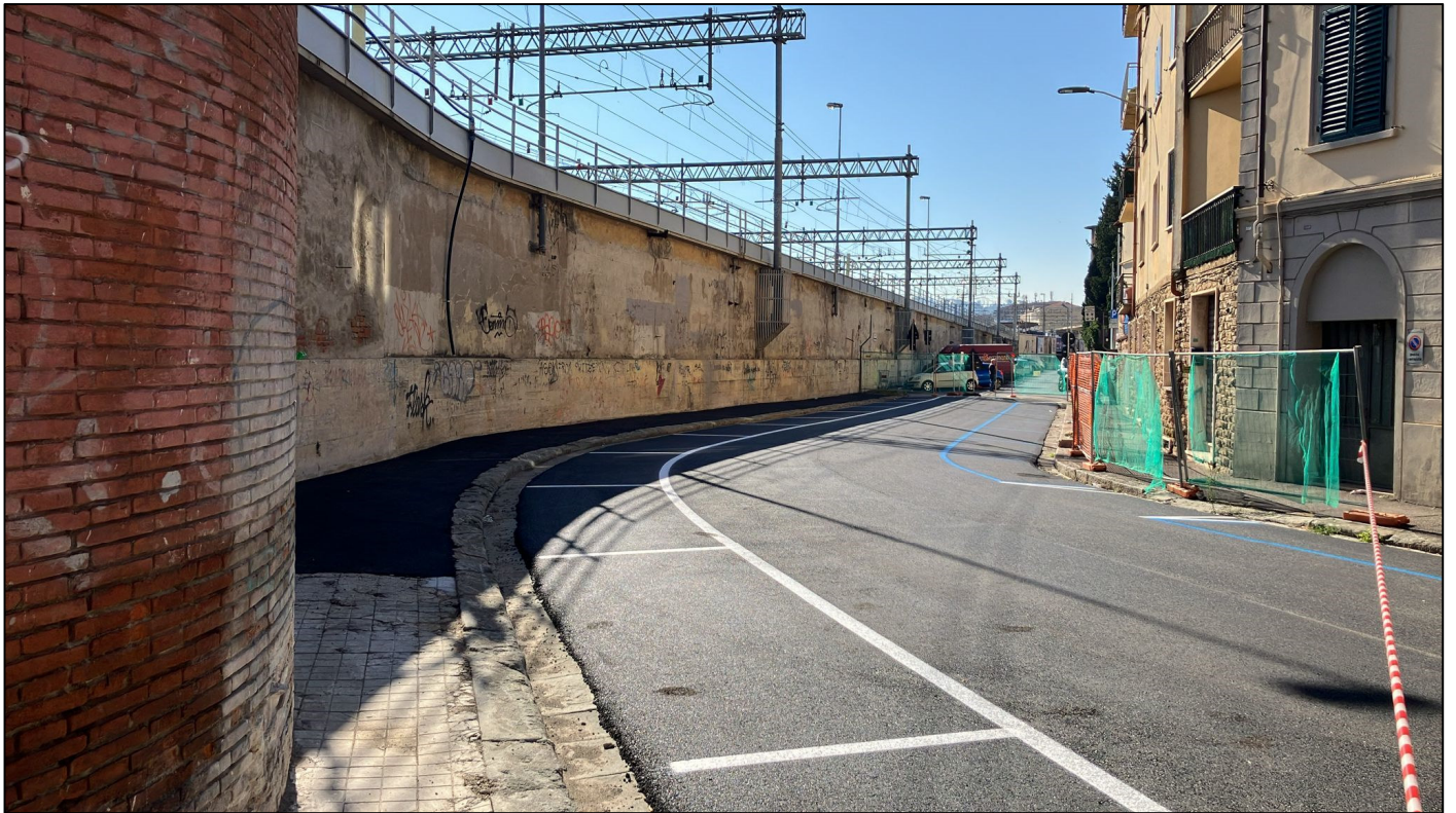
Figura 16 – Via delle Ghiacciaie (Edificio 35)
