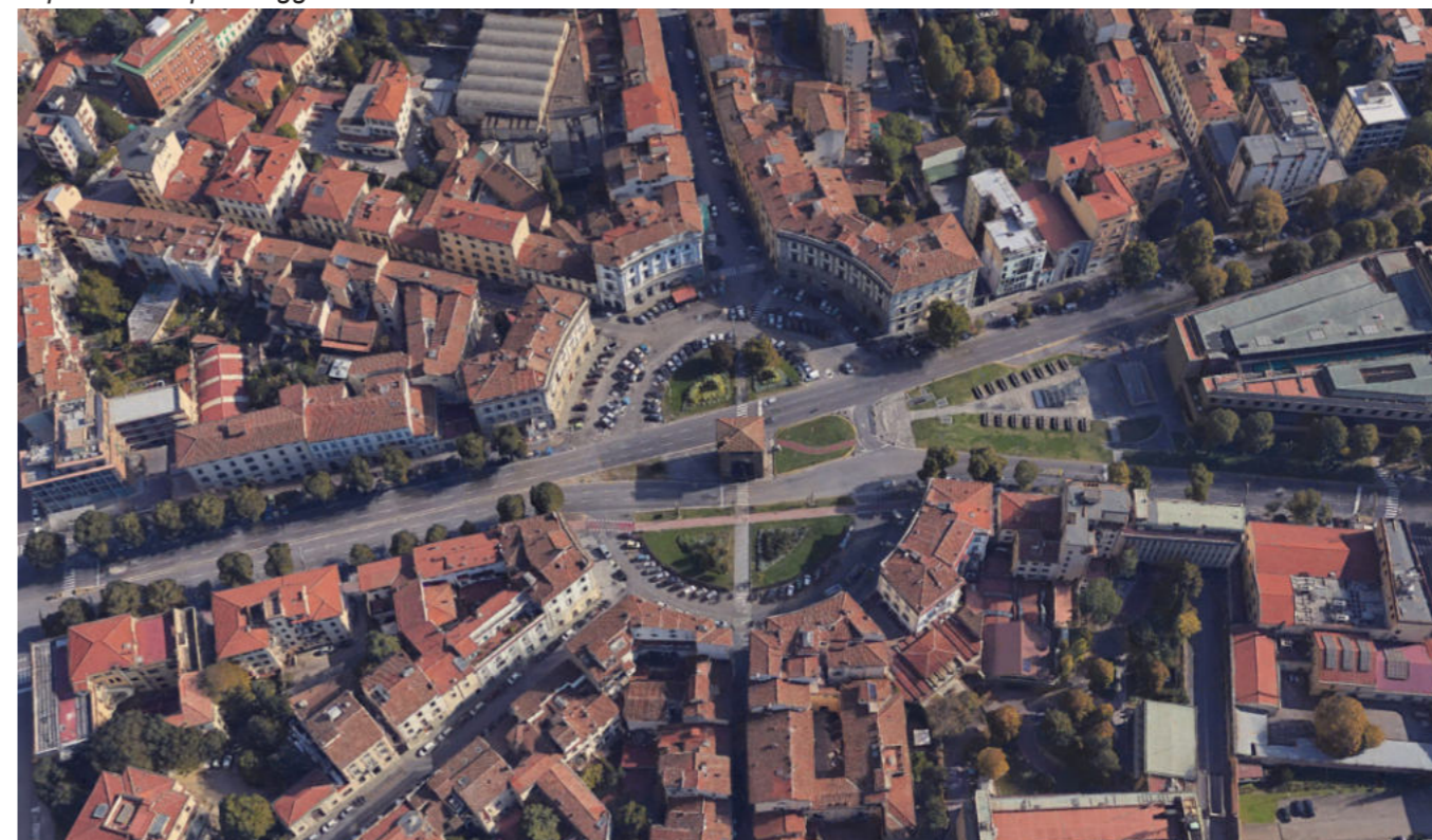
Piazzale Beccaria, vista dall'alto da nord est verso sud ovest.
