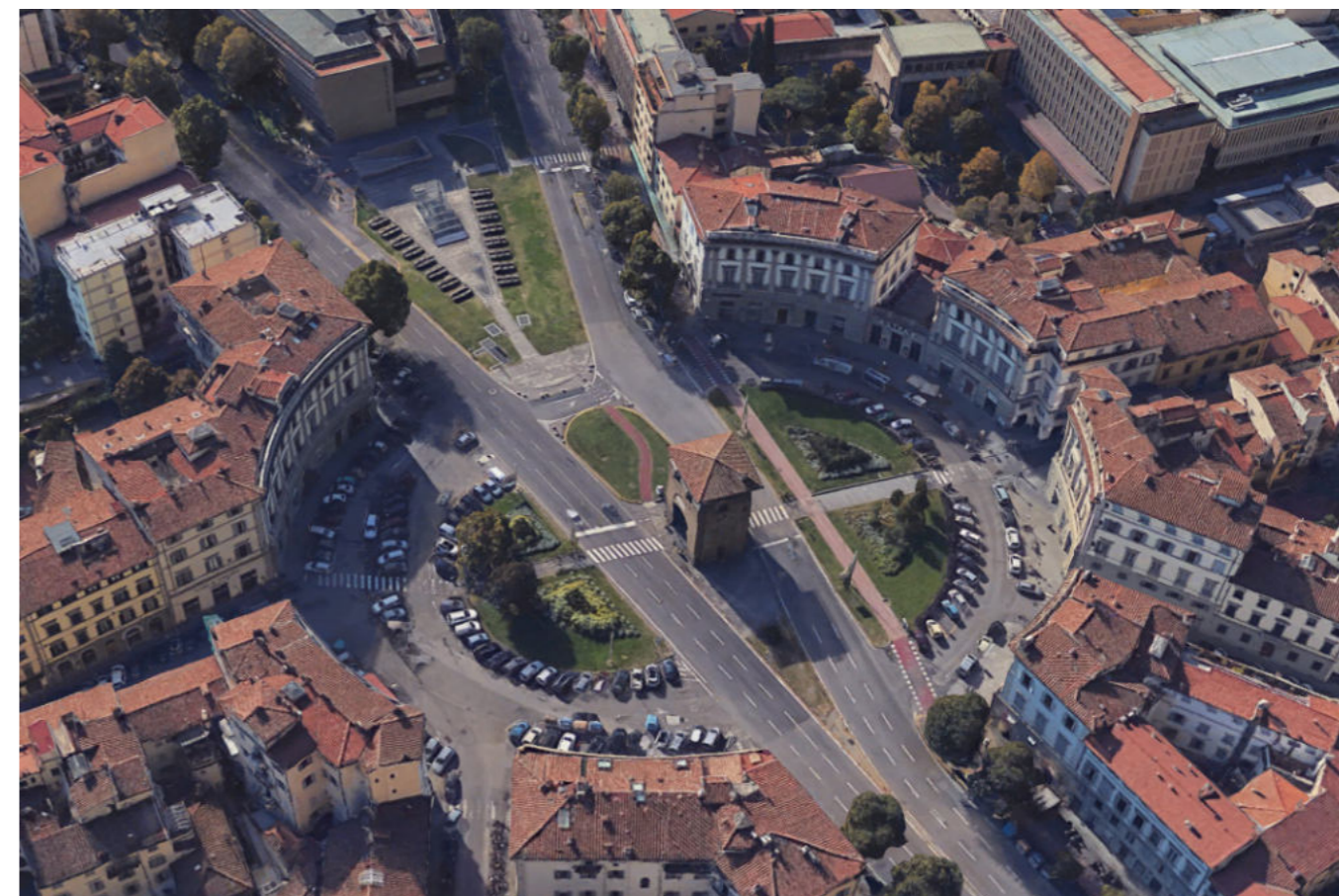
Piazzale Beccaria, vista dall'alto da nord est verso sud ovest. In alto il fronte sulla piazza dell'archivio di stato e la copertura del parcheggio interrato "beccaria"
