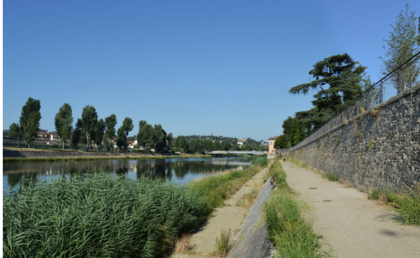
Sistemazione dell'argine destro (nord) in corrispondenza del nuovo ponte: foto dello stato attuale
