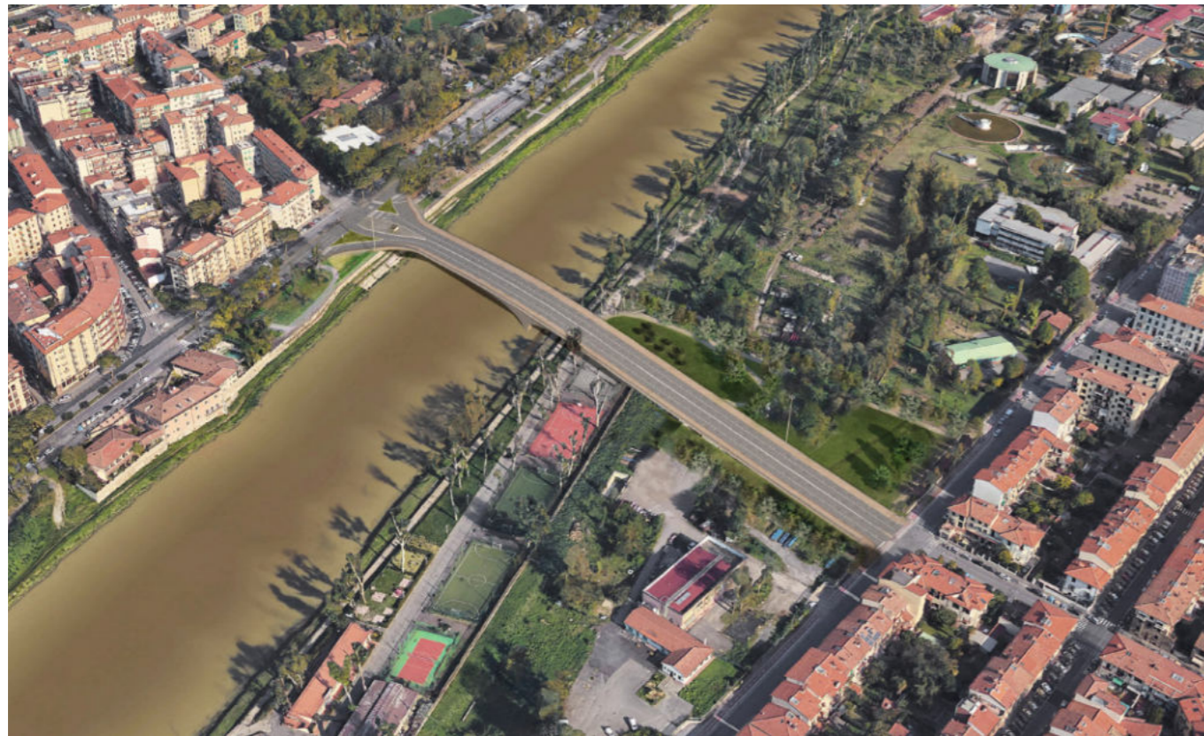
Immagine aerea della precedente soluzione del ponte a quattro corsie (soluzione D)
