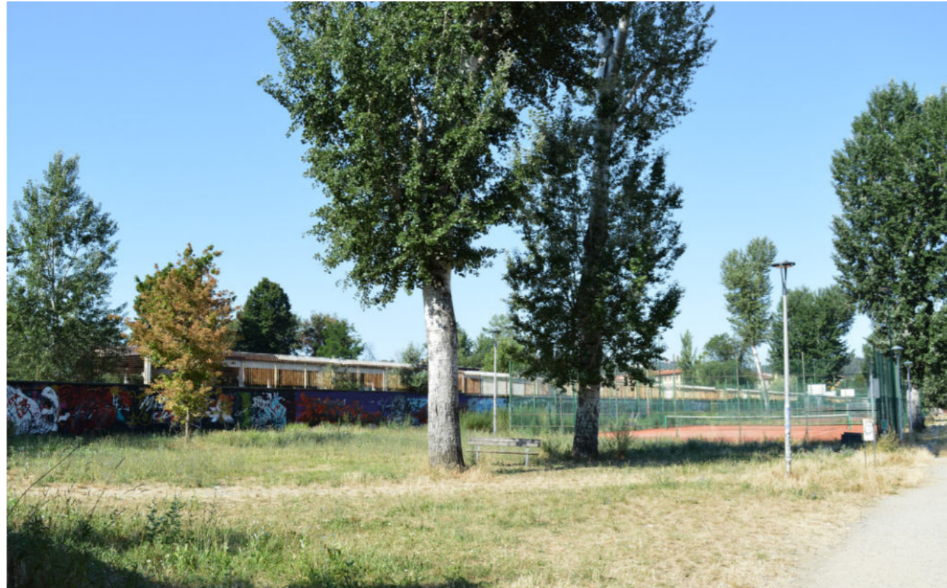
Sistemazione dell'argine sinistro (sud) in corrispondenza del nuovo ponte: foto dello stato attuale
