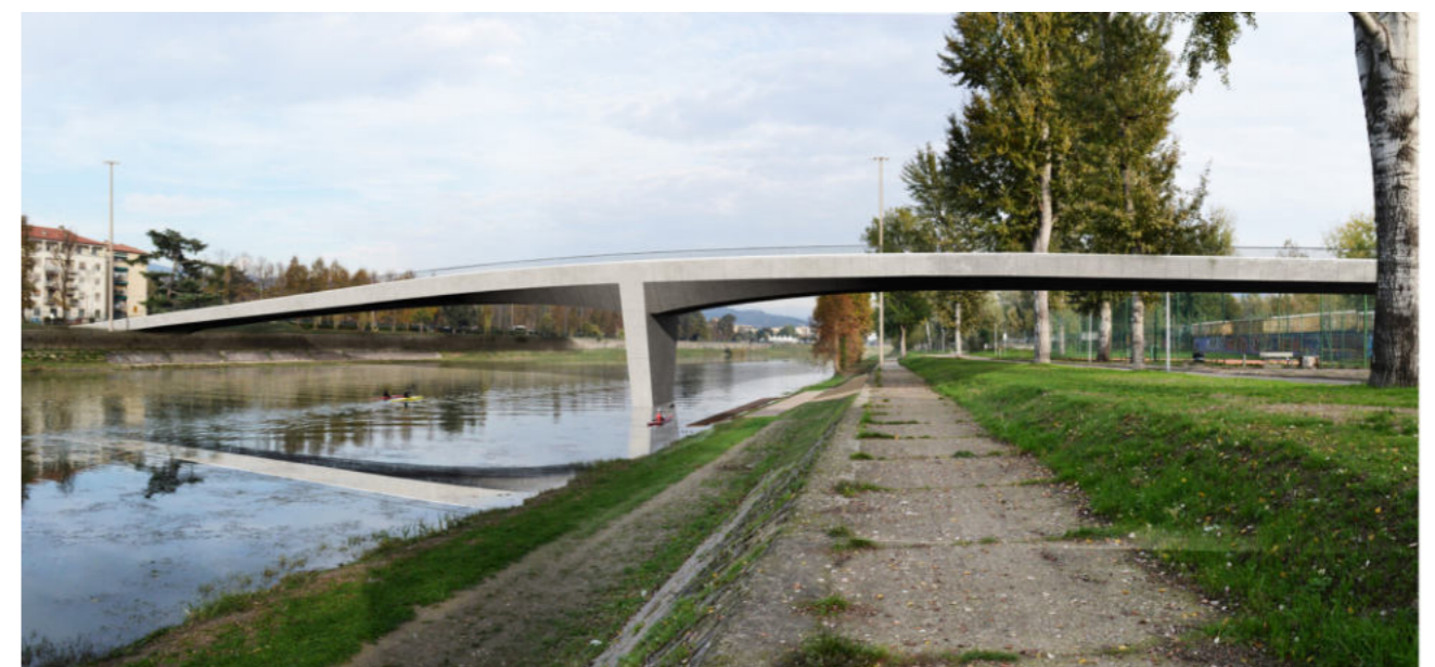
Vista verso est dall'argine sud con il fotoinserimento del nuovo ponte
