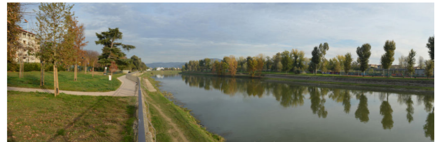
Nuovo ponte di Bellariva, Stato attuale, vista verso est dall'argine nord
