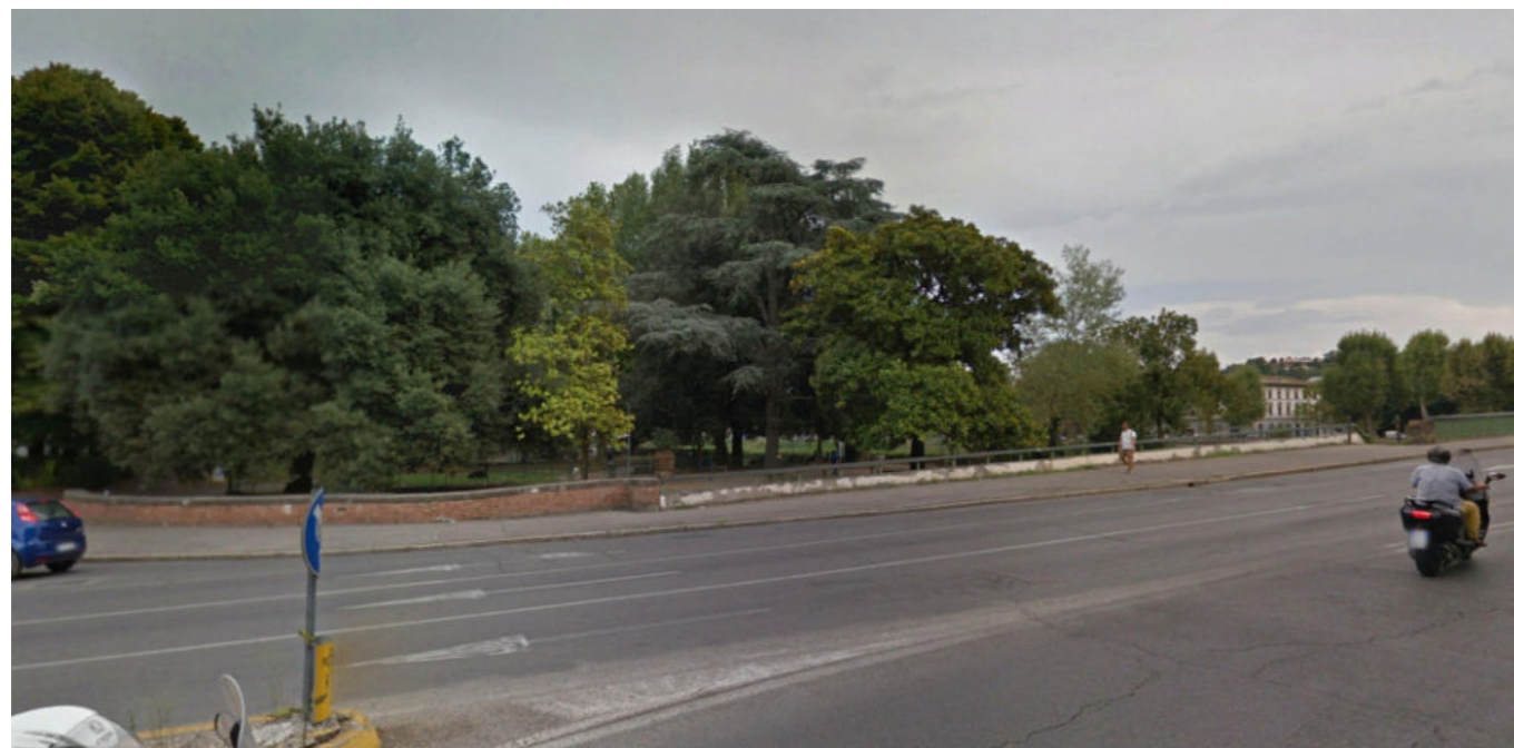
Sotto stazione elettrica San Niccolò: foto dello stato attuale
