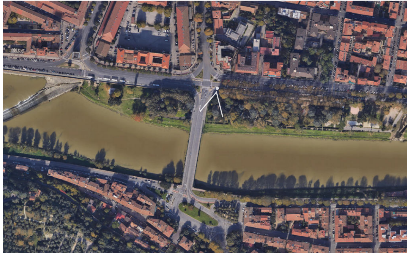
Sotto stazione elettrica San Niccolò: Foto aerea con punti di ripresa fotografica
