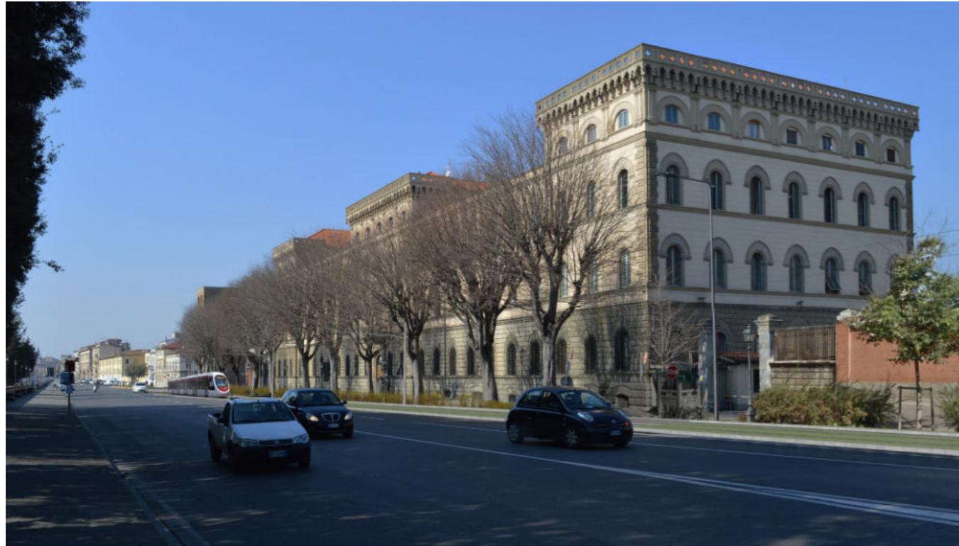
Lungarno Pecori-Giraldi Fronte sull'Arno della Caserma Baldissera dall'ingresso di Ponte San Niccolò, Stato attuale
