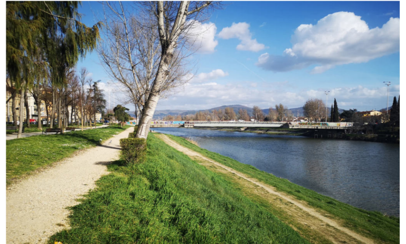
foto 1: il ponte da Verrazzano dall'argine destro, verso sud, stato attuale
