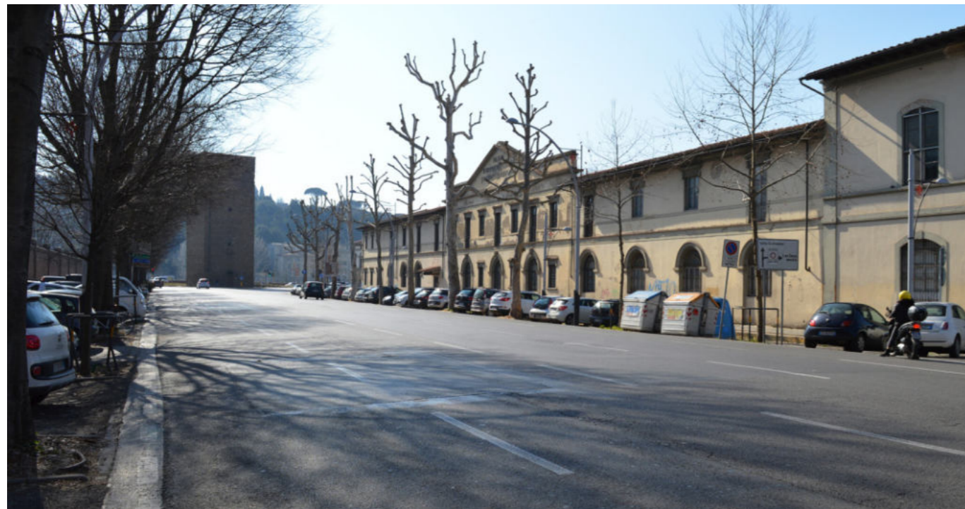
Viale della Giovine Italia, vista verso la Torre della Zecca a sud e sullo sfondo il Piazzale Michelangelo, stato attuale
