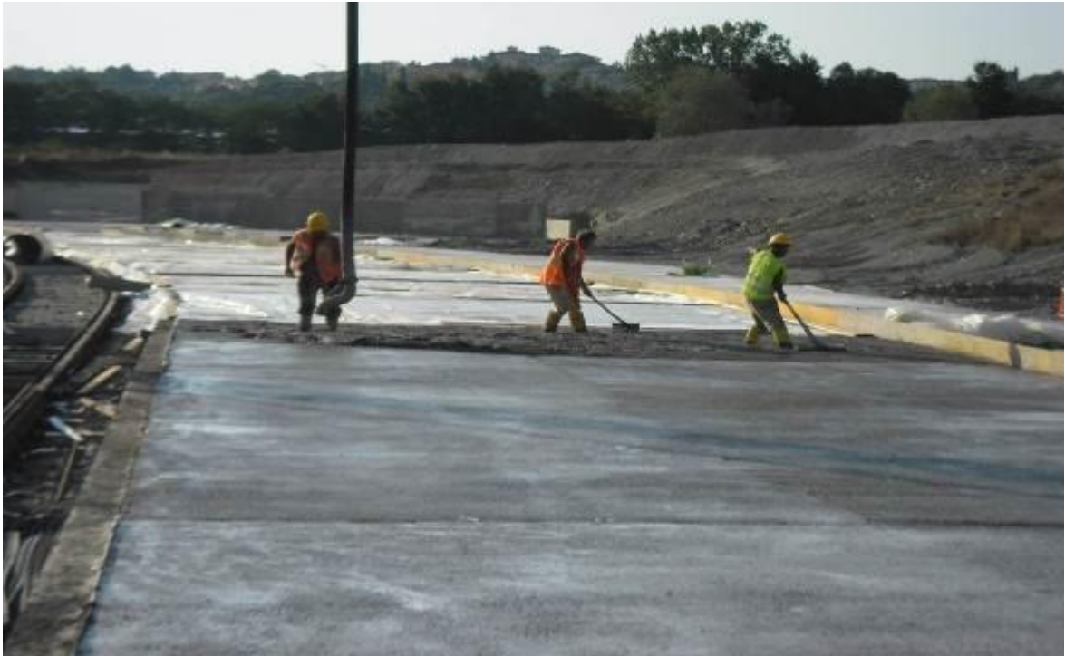
FOTO 2 – Completamento Terminal Bricchette
