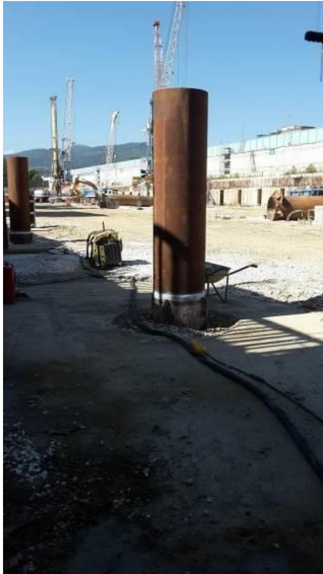
FOTO 2 – Prolungamento colonne per Appoggio Solaio Piano Terra
