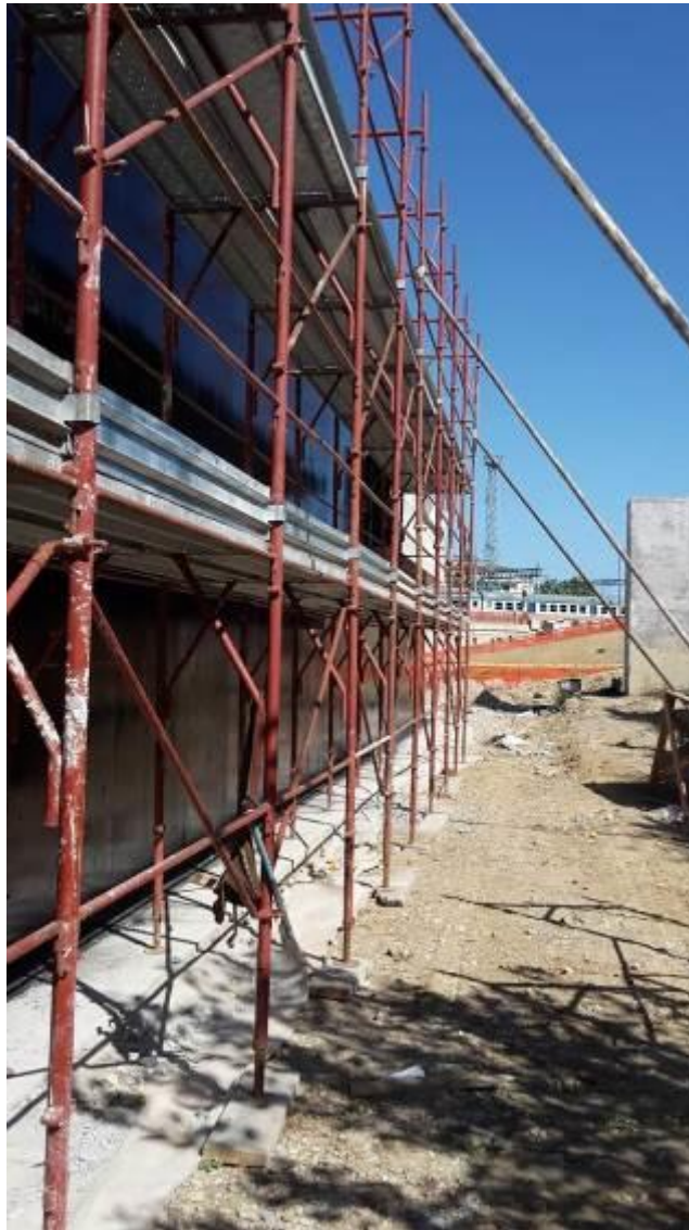
FOTO 1 – Posa guaina impermeabilizzante muro Rampa Kiss&Ride
