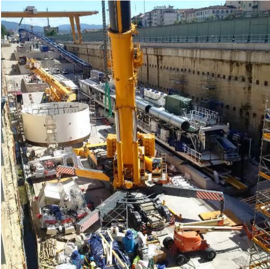
FOTO 1 – Montaggio TBM
