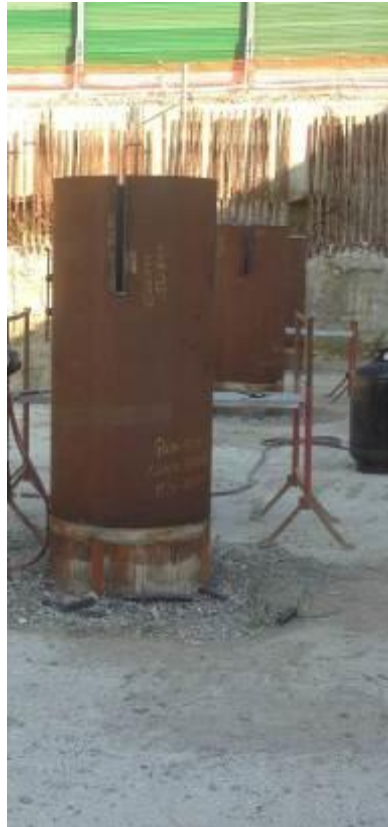
FOTO 3 – Predisposizioni per carpenterie metalliche testata Nord
