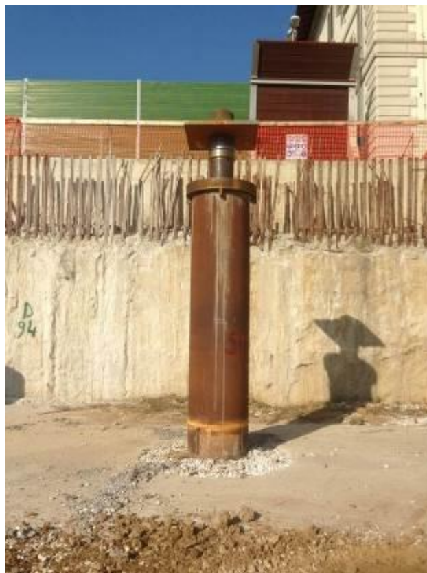
FOTO 4 – Montaggio carpenterie metalliche su colonne
