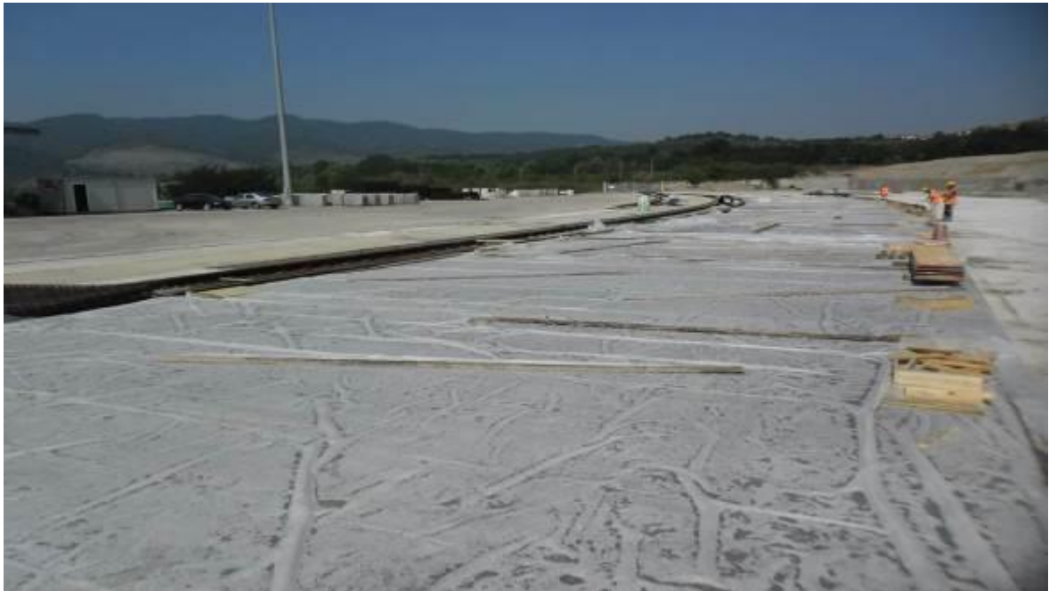
FOTO 3 – Completamento Terminal Bricchette
