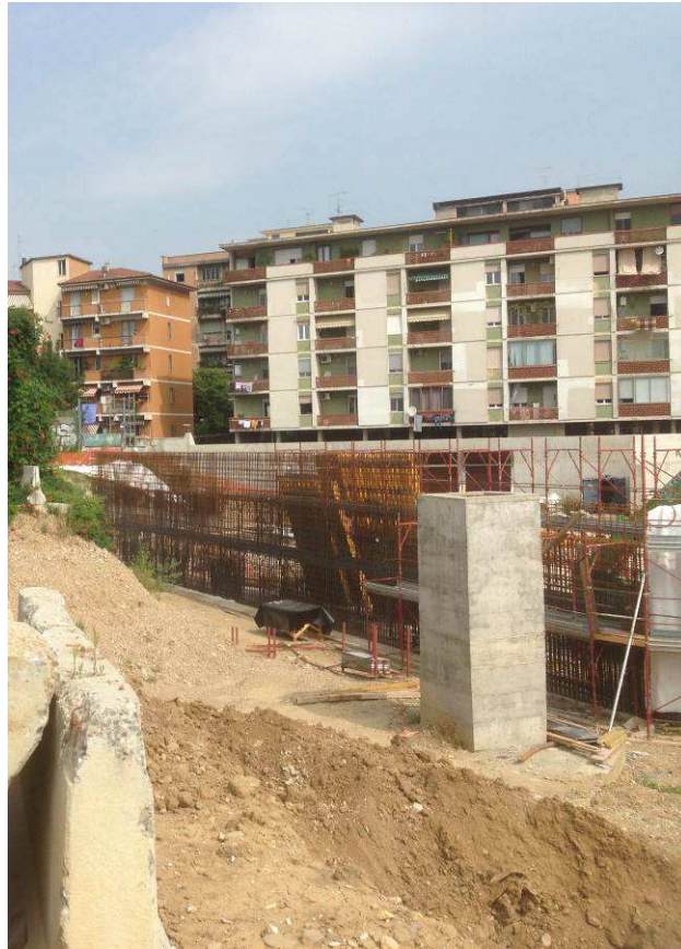
FOTO 2– Realizzazione della prima parete della Rampa Kiss&Ride
