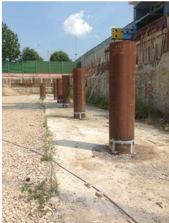
FOTO 3– Prolungamento colonne per Appoggio Solaio Piano Terra
