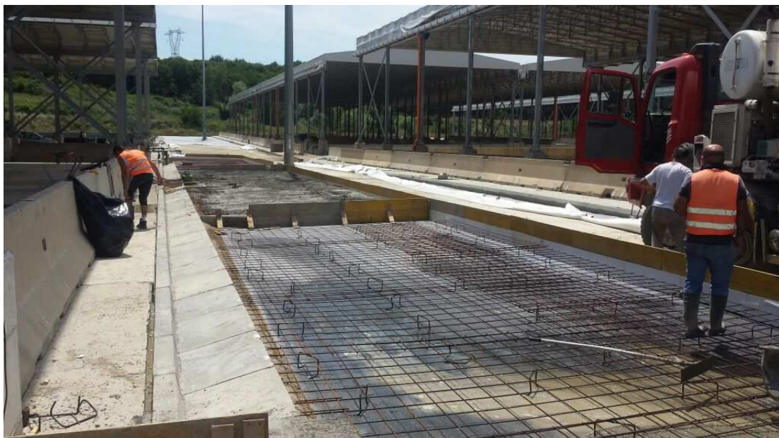
FOTO 1 – Completamento Viabilità Piazzole 7 e 8
