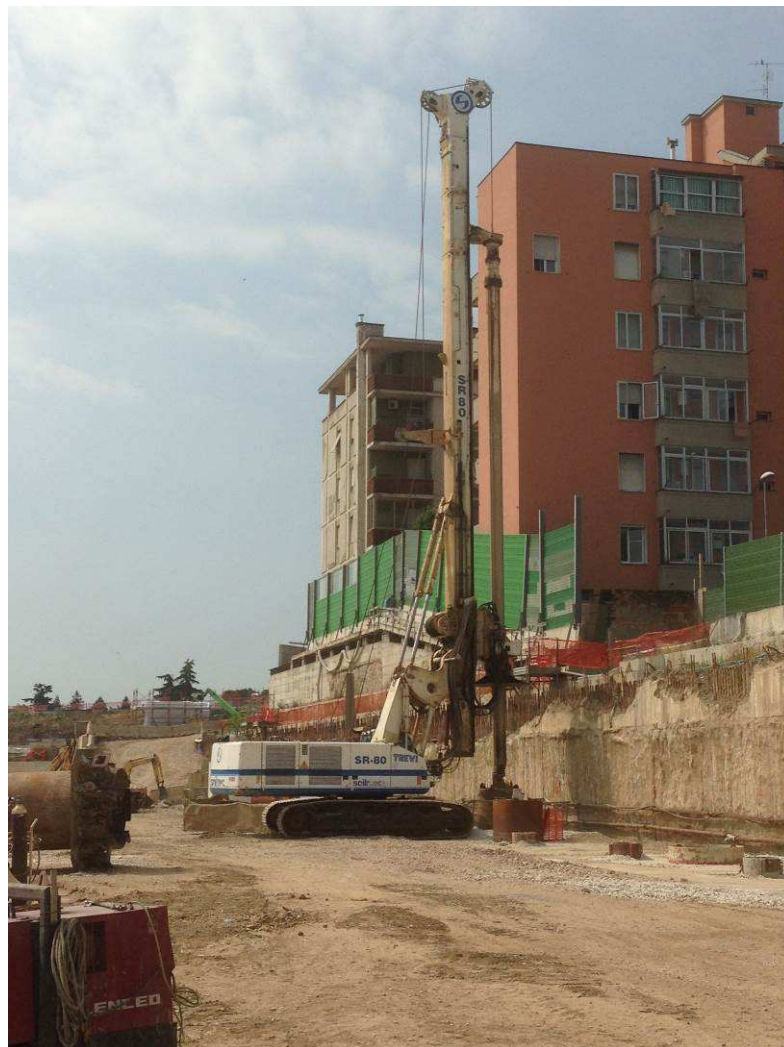
FOTO 1– Realizzazione pali di fondazione camerone Stazione AV
