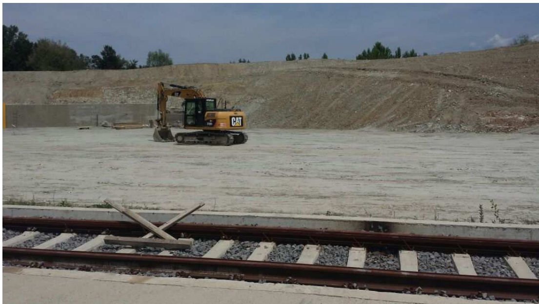
FOTO 3 – Completamento Terminal Bricchette
