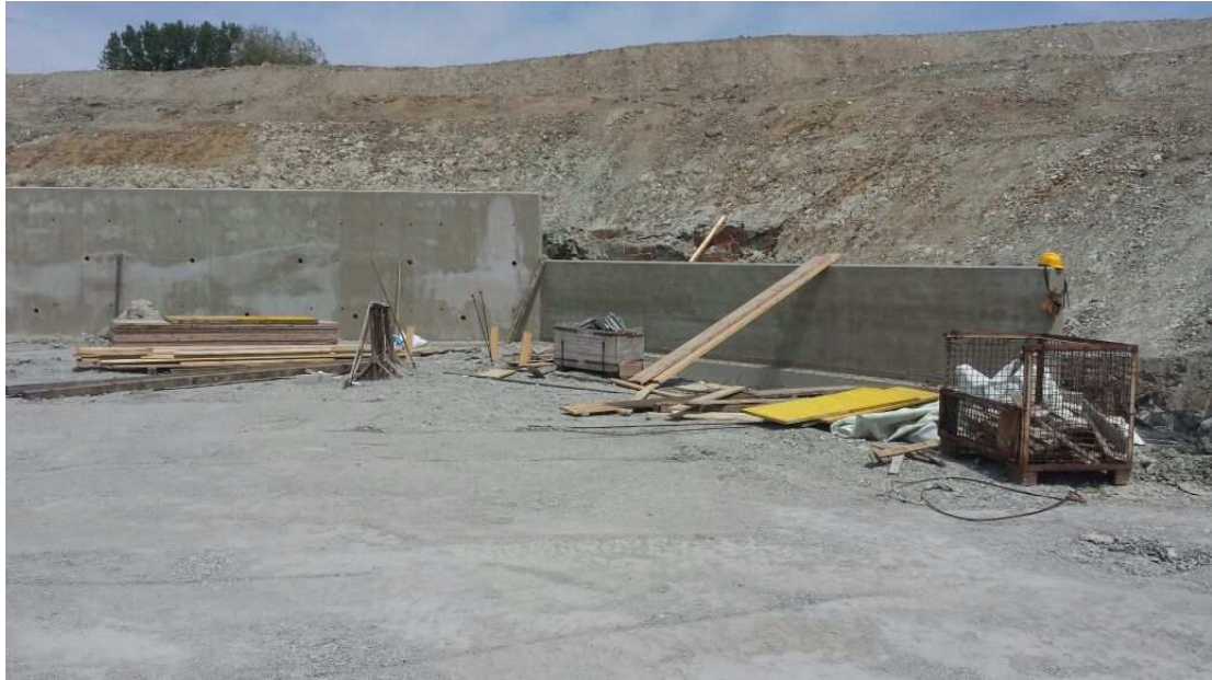
FOTO 2 – Completamento Terminal Bricchette
