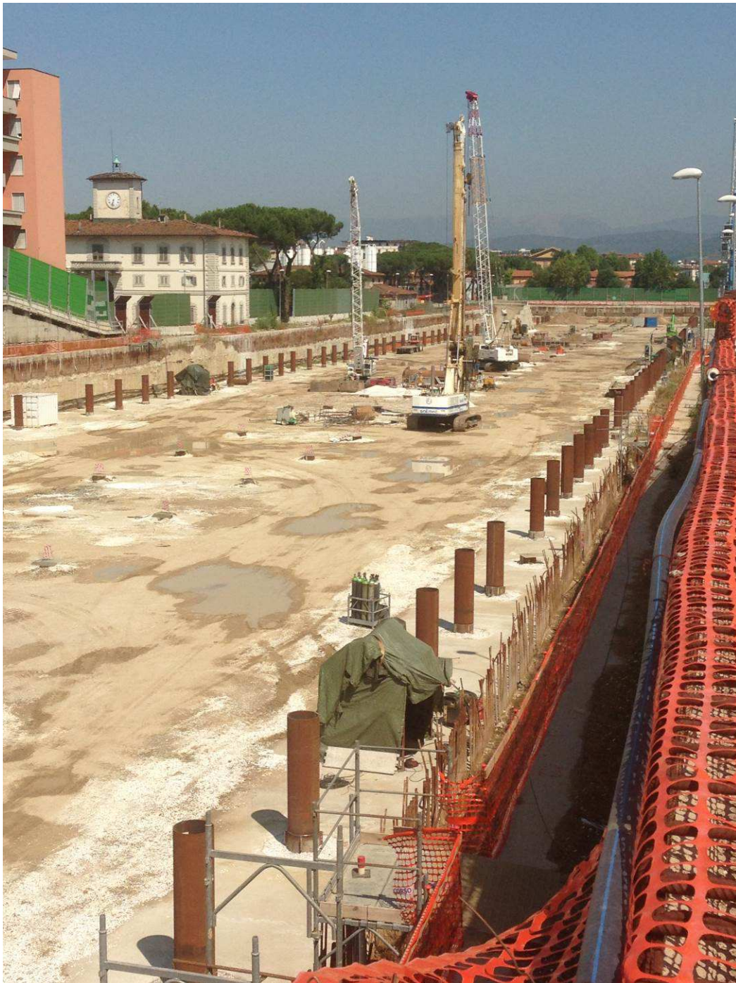
FOTO 2– Prolungamento colonne per Appoggio Solaio Piano Terra
