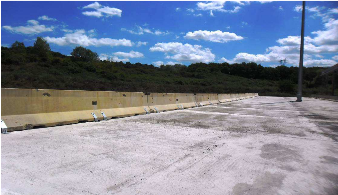
FOTO 1 – Completamento soletta pavimentazione viabilità
