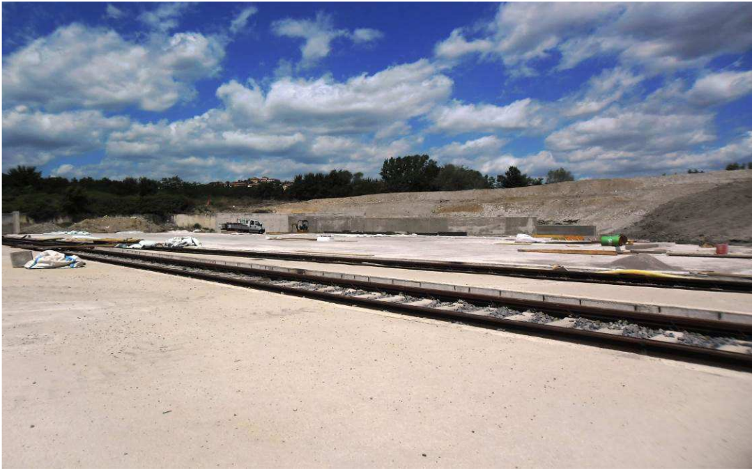
FOTO 3 – Completamento terminal Bricchette
