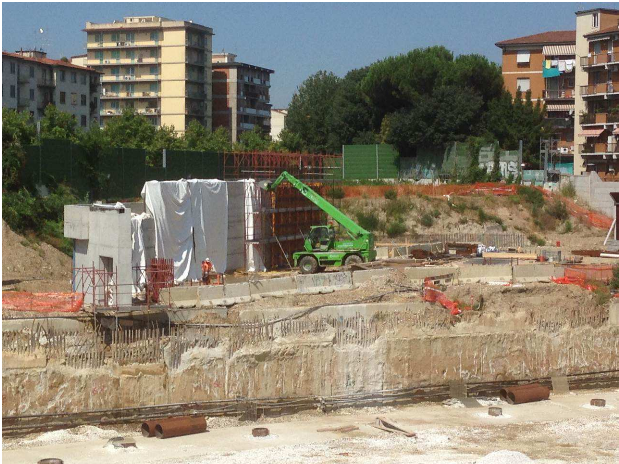
FOTO 1– Realizzazione della prima parete della Rampa Kiss&Ride
