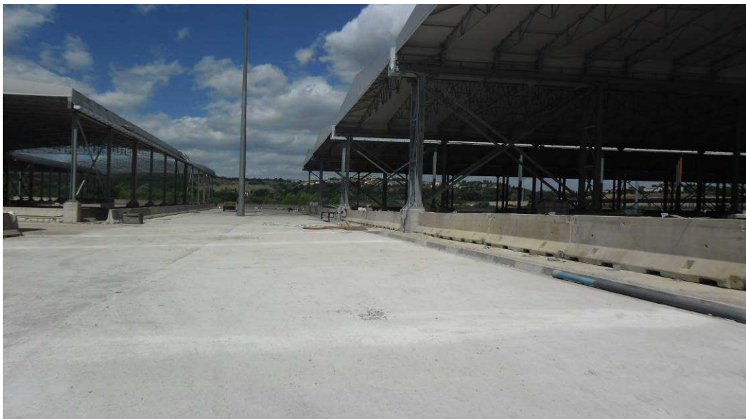
FOTO 2 – Completamento soletta pavimentazione viabilità
