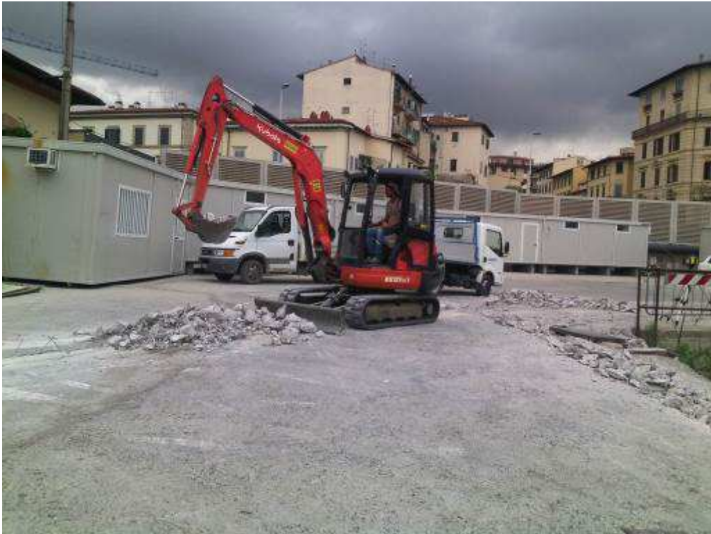
Foto 4 – Regimazione acque al di sopra del pozzo lancio Fresa
