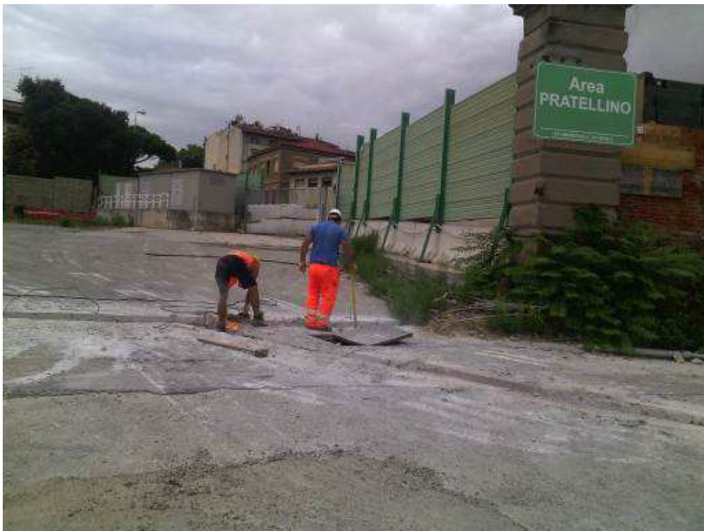
Foto 5 - Regimazione acque al di sopra del pozzo lancio Fresa
