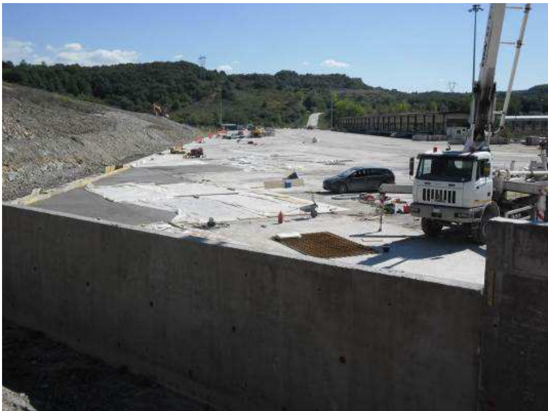
Foto 7 - Completamento Terminal Bricchette
