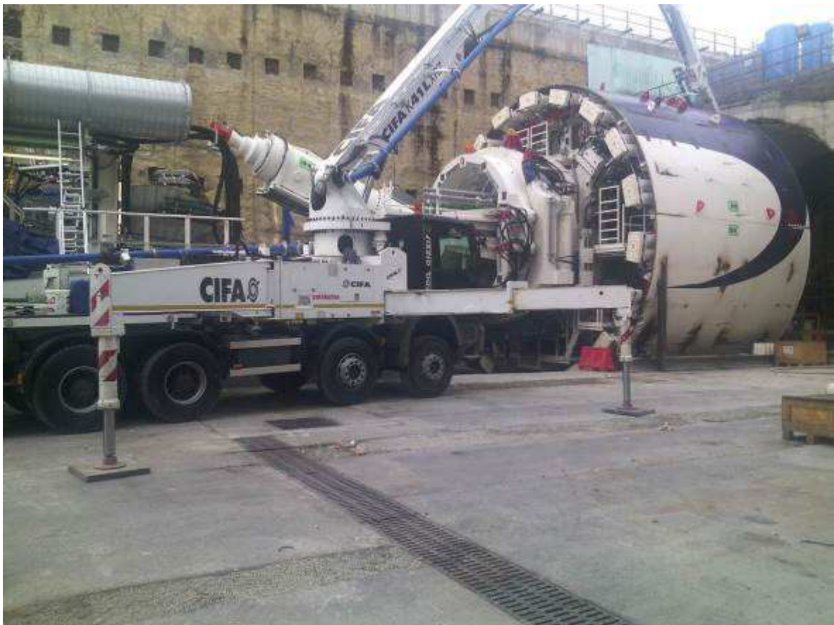
Foto 3 - Carpenteria e getto per preparazione imbocco
