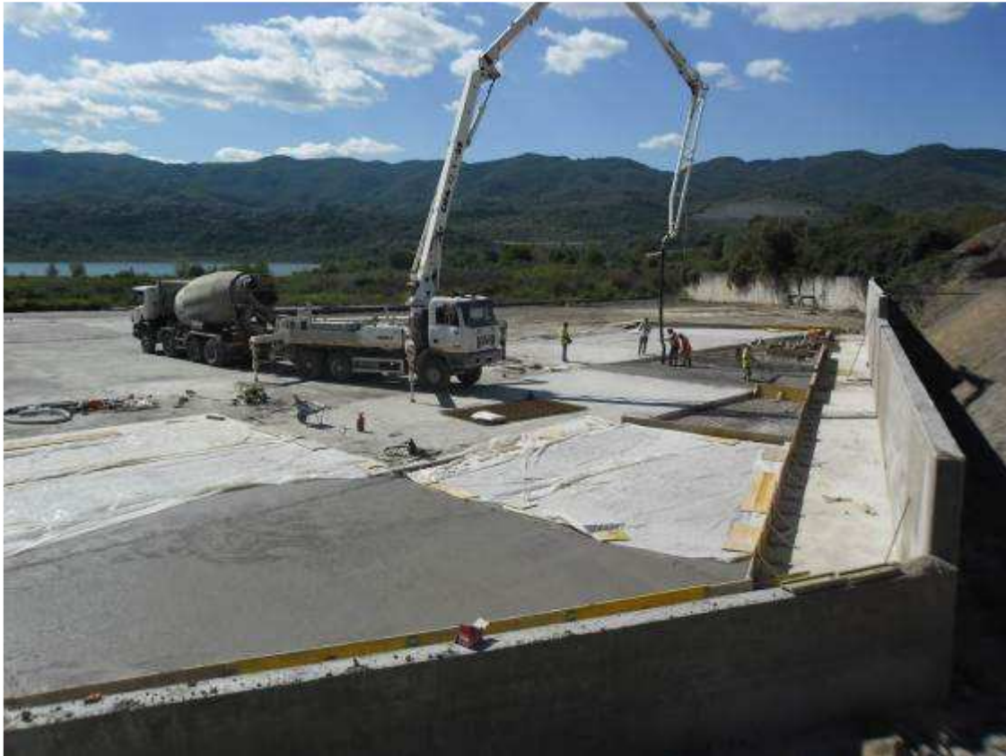
Foto 8 - Completamento Terminal Bricchette
