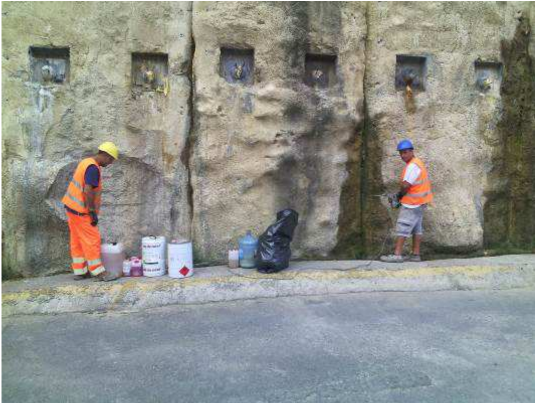
Foto 6 - Interventi per risoluzione nc 122
