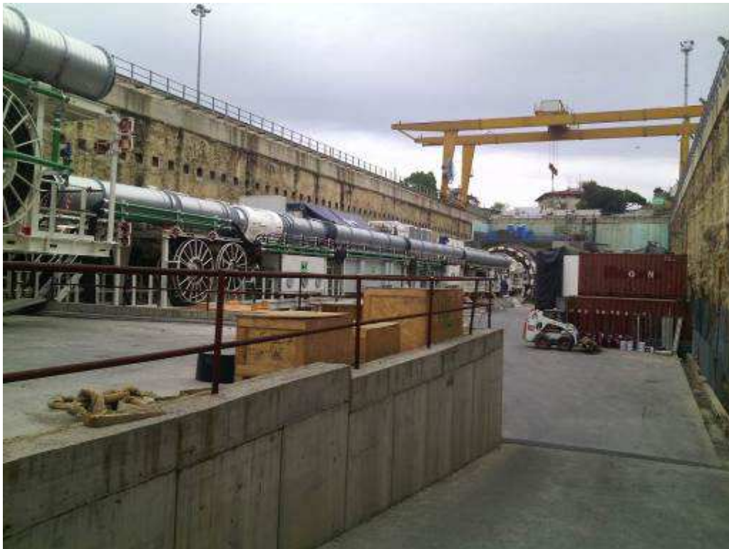
Foto 2 - Montaggio TBM
