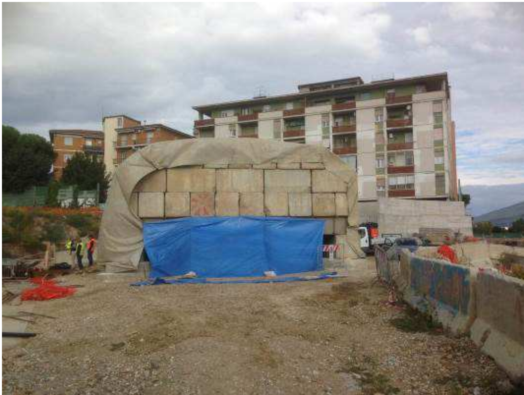
Foto 3 - Prove di carico su pali fondazione rampa Kiss&Ride
