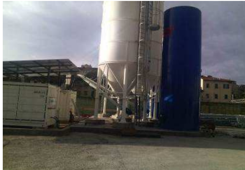
Foto 3 – Installazione impianti di cantiere
