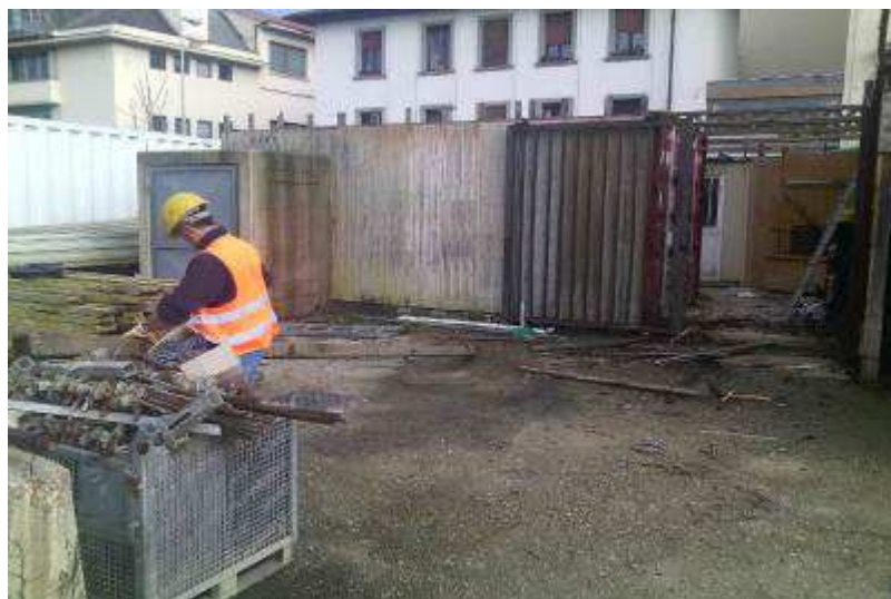
Foto 4 - Smontaggio box cantiere zona uffici
