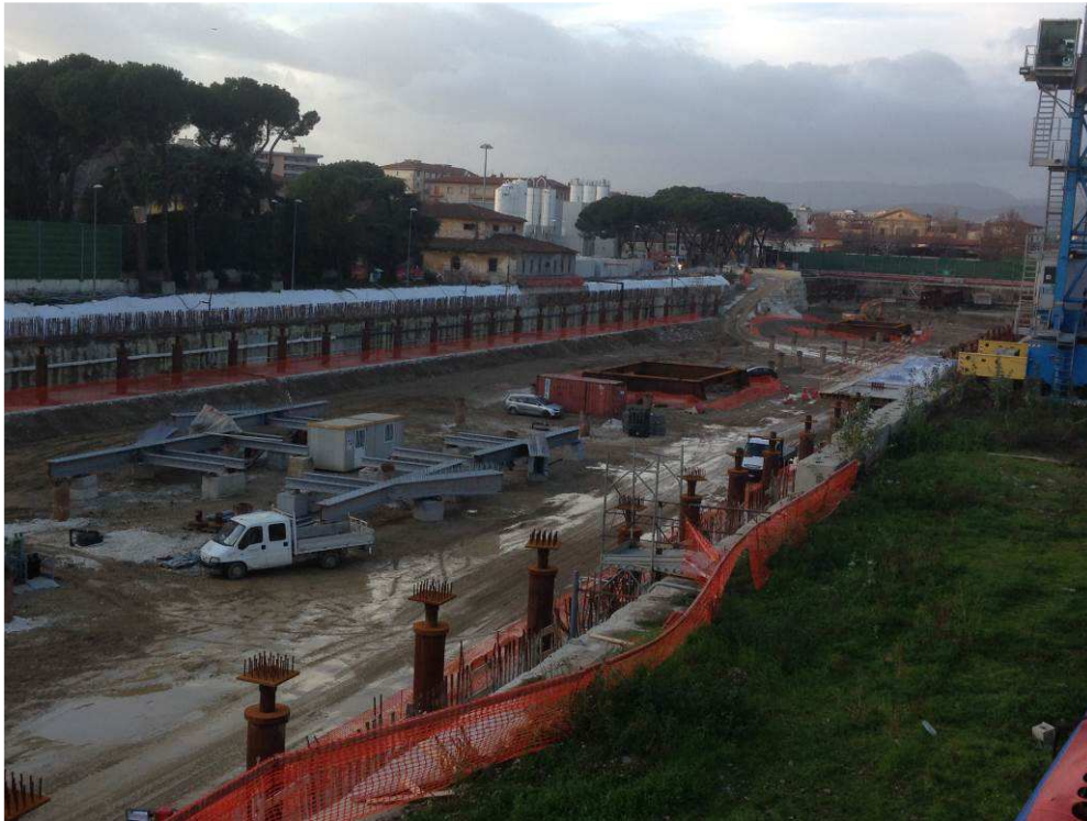
Foto 2 - Demolizione cordolo guida esterno diaframmi Camerone
