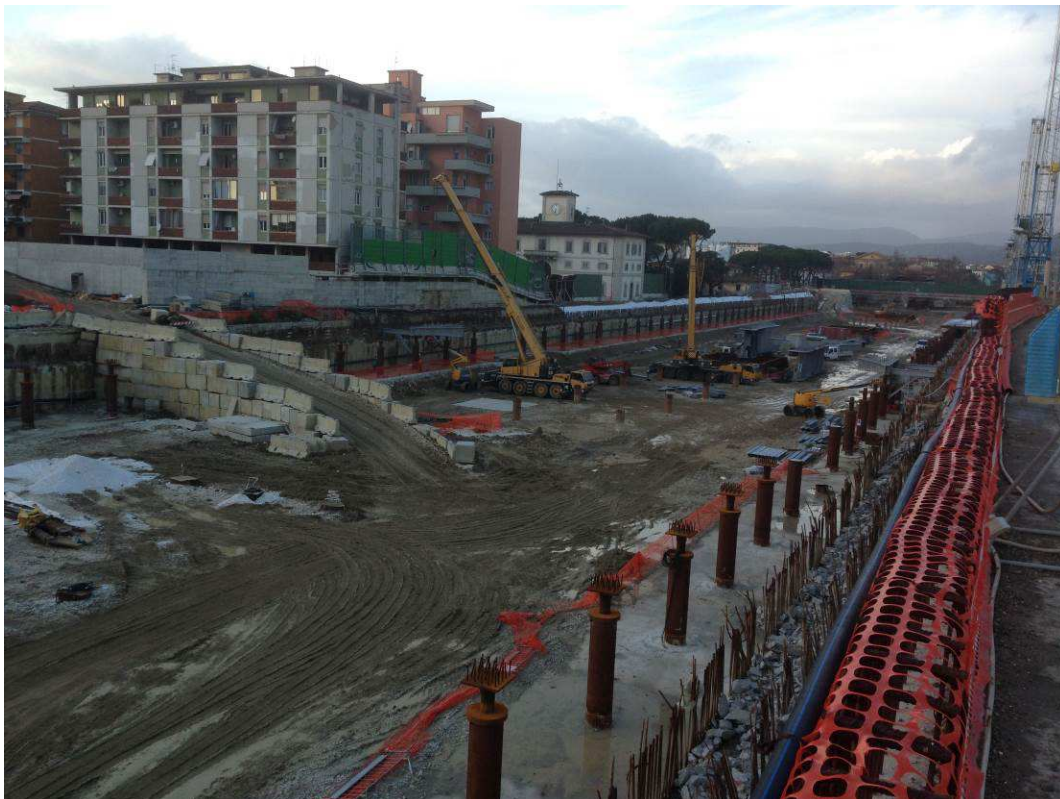
Foto 1 - Vista d'insieme del Camerone di Stazione AV
