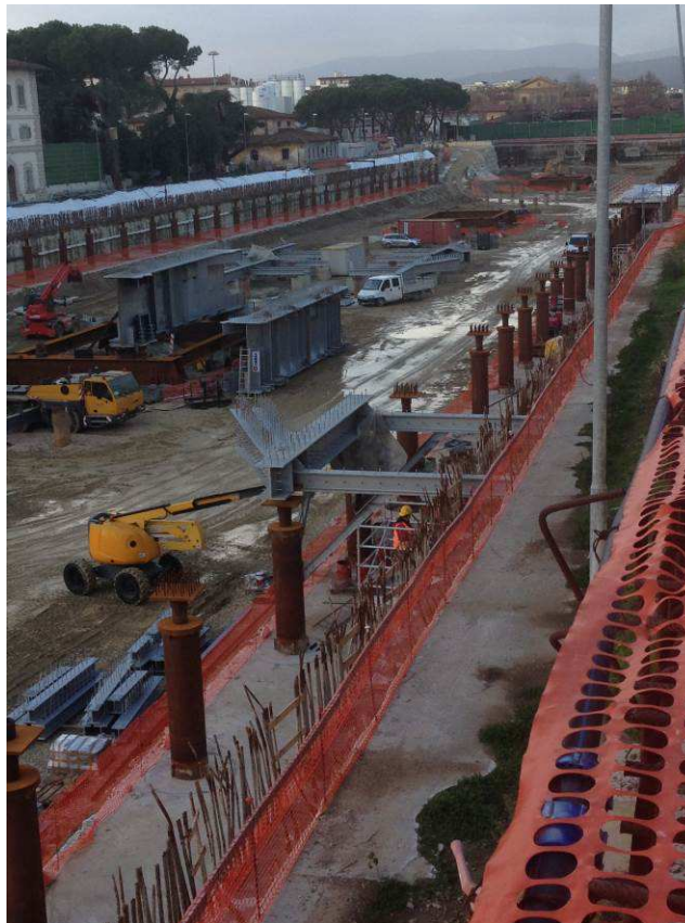
Foto 3 – Montaggio Carpenteria metallica Solaio Piano Terra
