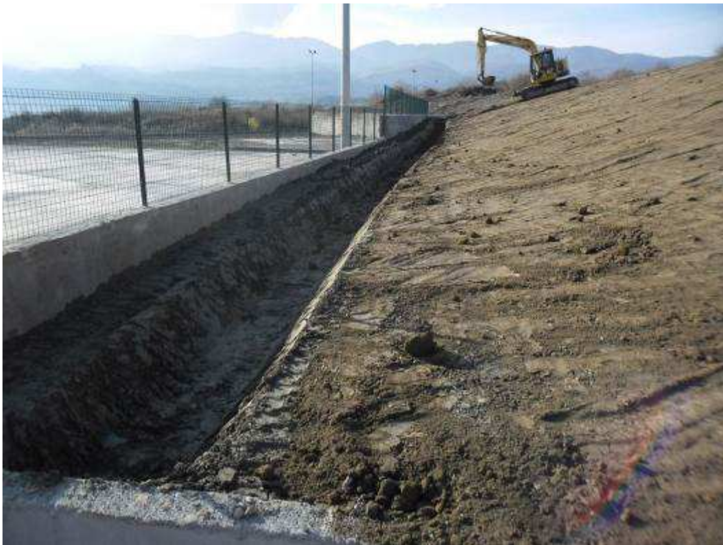
Foto 6 – Ripristino cunette Idrauliche Viabilità
