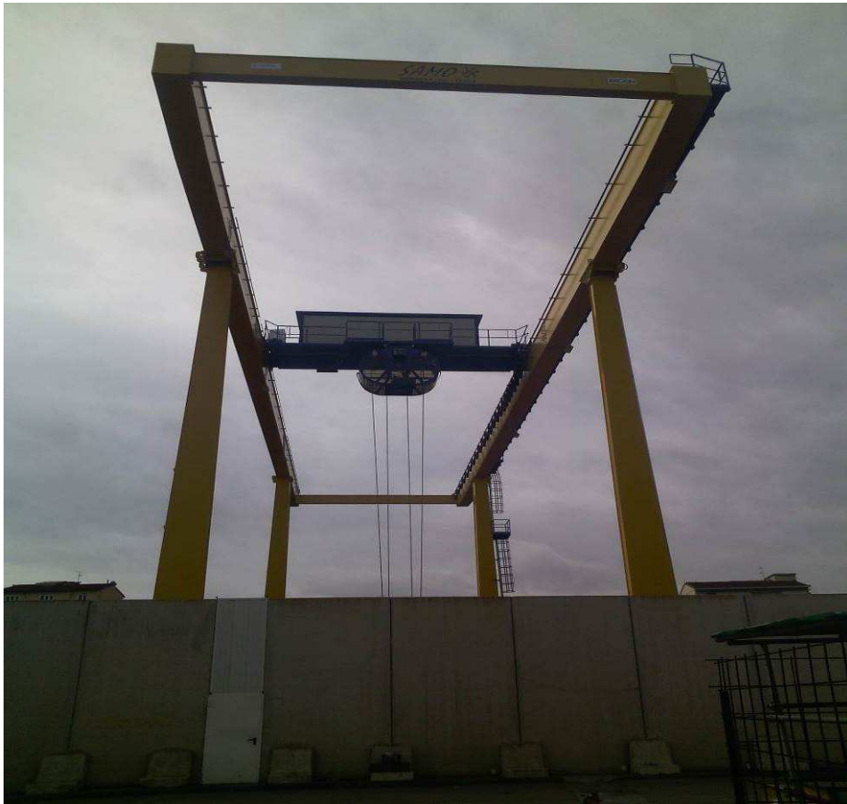
Foto 1 - Montaggio carro ponte
