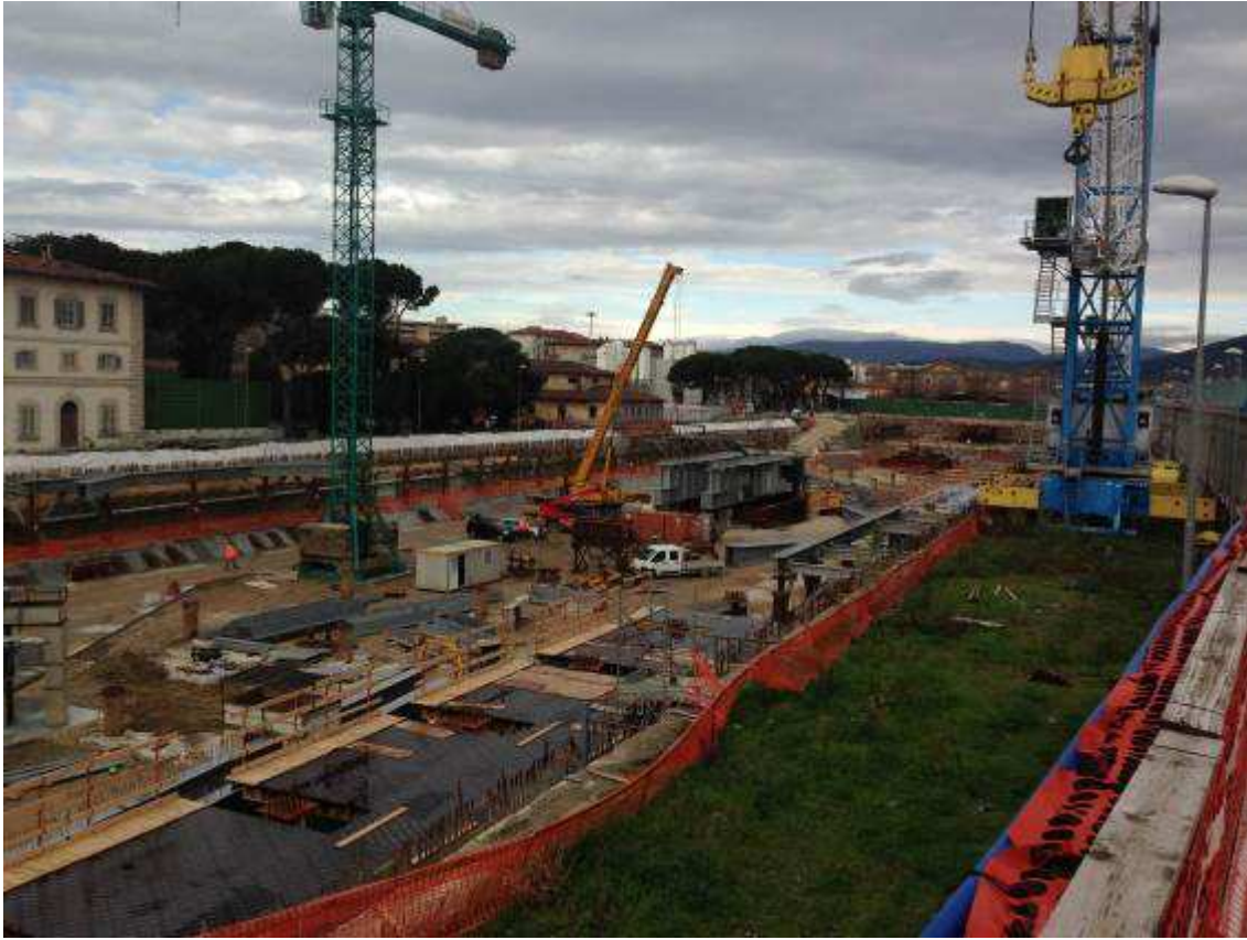
Foto 4 – Montaggio gru a torre
