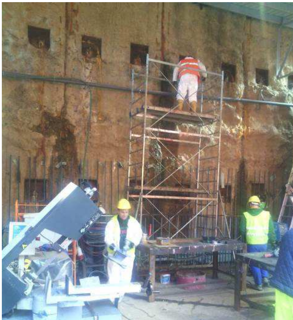
Foto 3 – Chiusura infiltrazioni
