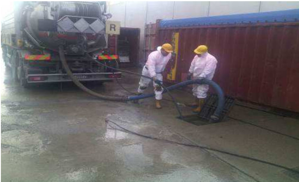
Foto 2 – Pulizia fognatura acque meteoriche
