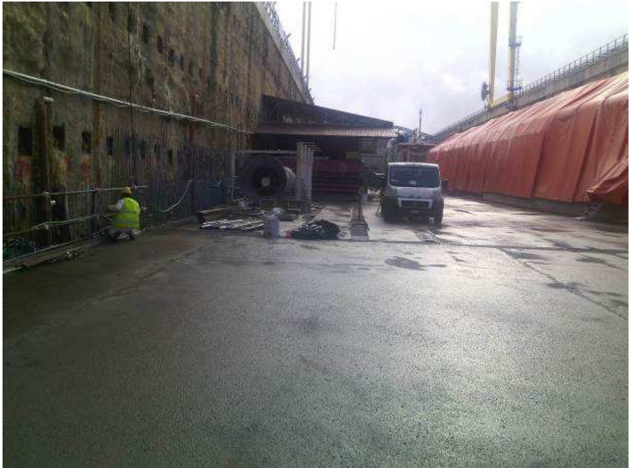
Foto 1 – Mantenimento e controllo TBM
