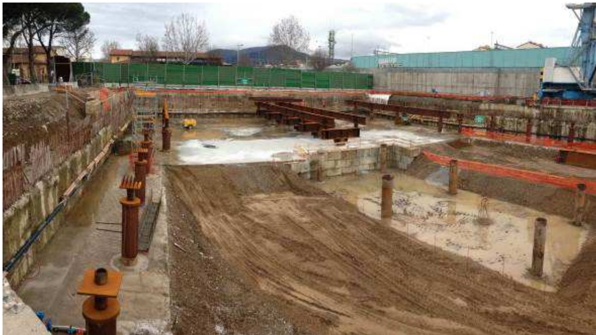
Foto 1 – Testata Nord Camerone di Stazione AV
