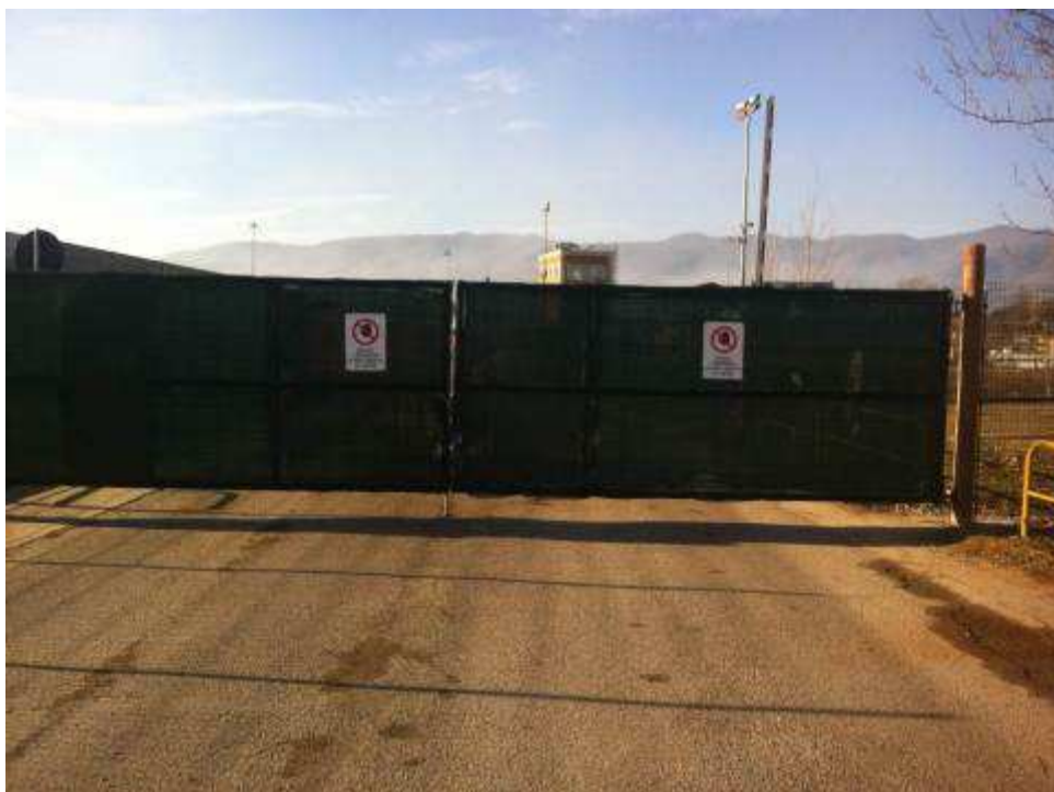
Foto 7 – Realizzazione cancello d'ingresso corridoio Enel
