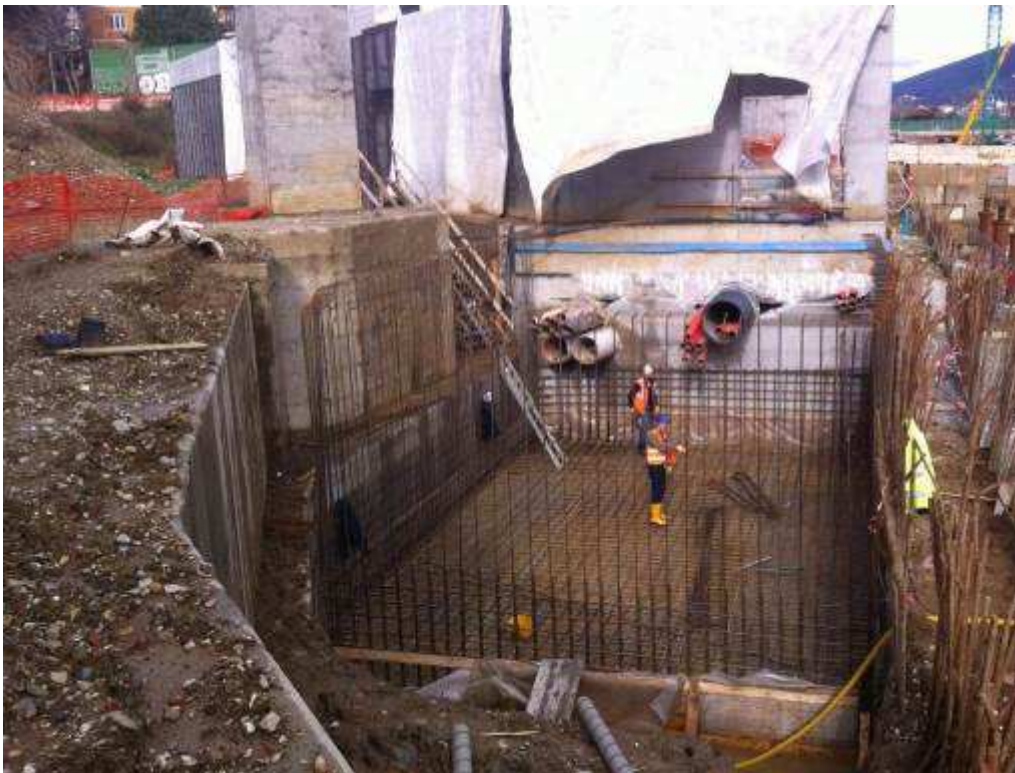
Foto 5 – Vasca di accumulo acque meteoriche presso la Rampa K&R
