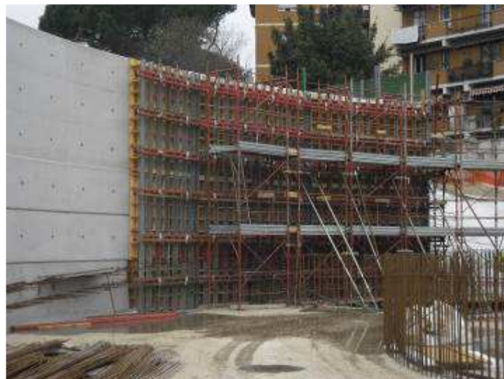
Foto 7 – Realizzazione elevazione Rampa K&R
