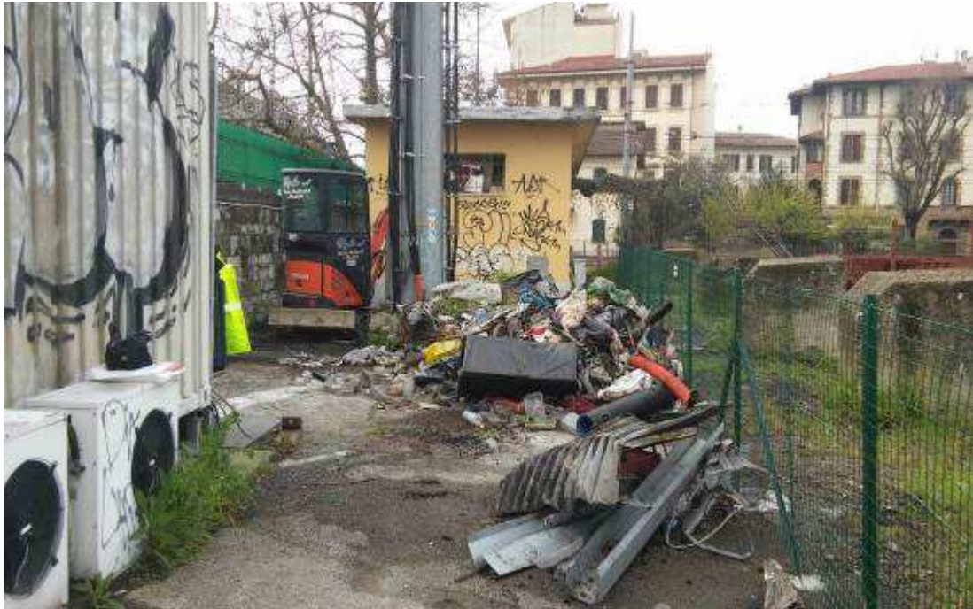
Foto 2 – pulizia zona AFFRICO Cantiere CDM (prima)
