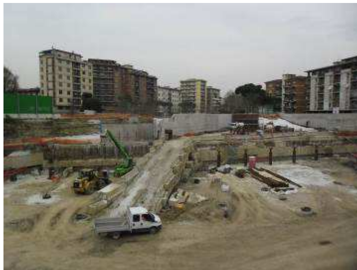
Foto 6 – Realizzazione elevazione Rampa K&R
