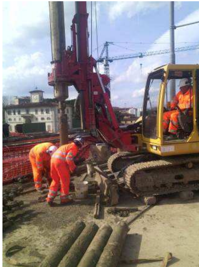
Foto 9 – Realizzazione pozzi di presa corridoio attrezzato
