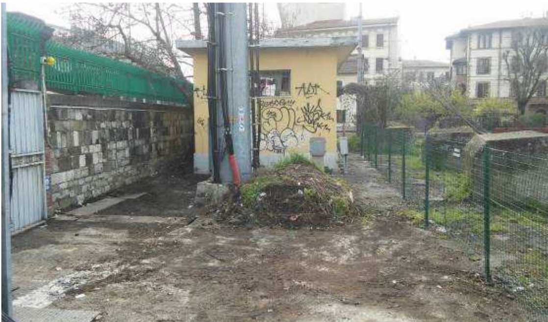
Foto 3 – pulizia zona AFFRICO Cantiere CDM (dopo)
