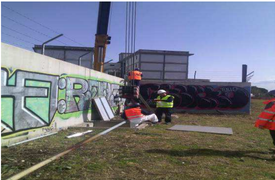
Foto 1 – sostituzione pompa pozzo lato Farmaceutico (scavalco)
