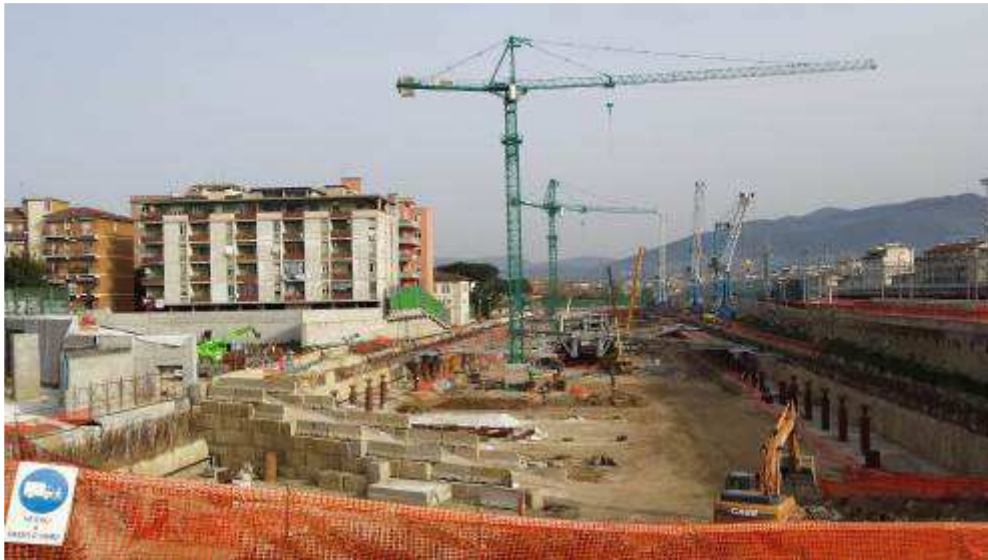
Foto 5 – Panoramica da SUD
