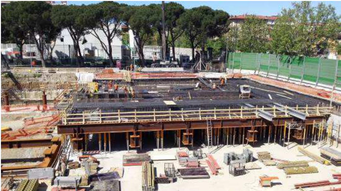
Foto 1 – Lavorazioni Testata Nord – Filo 1-3
