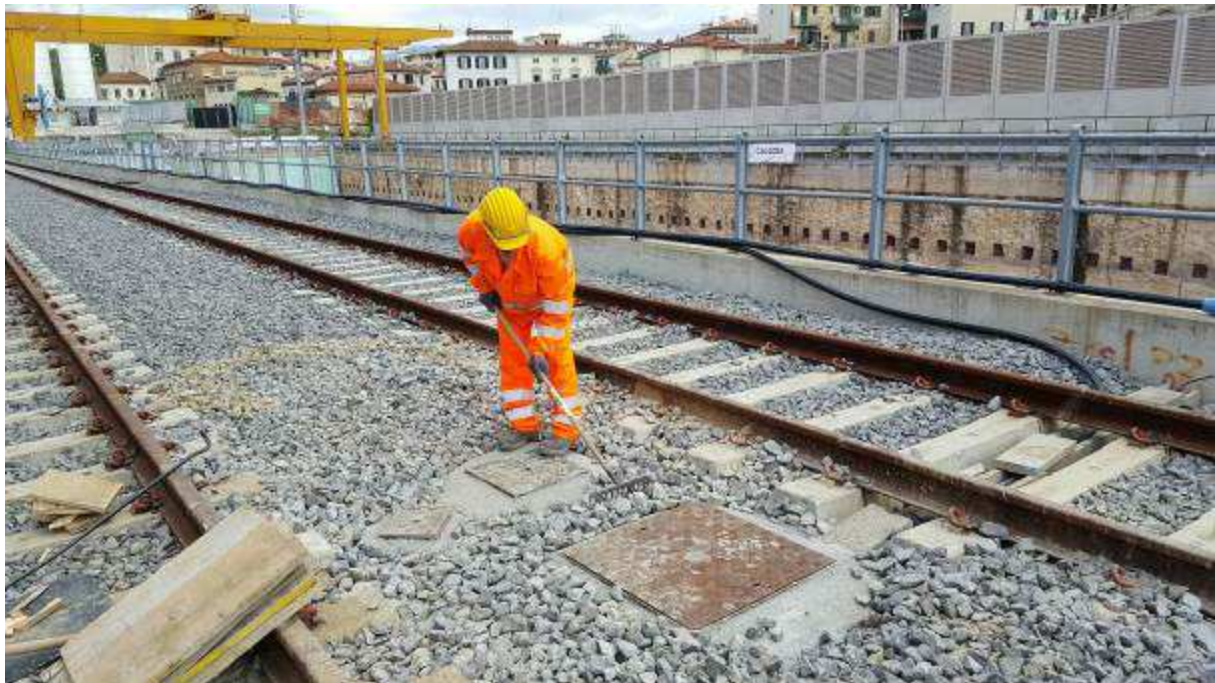
Foto 1 – muratura pozzetti piezometri (Cantiere CDM)
