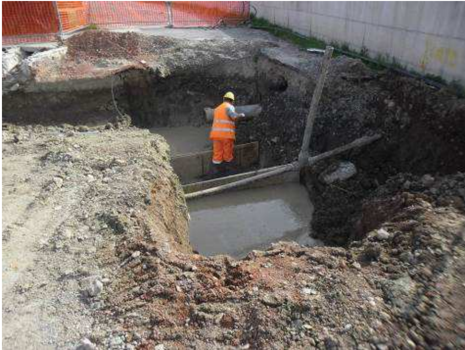
Foto 2 – Risoluzione interferenza antincendio Enel
