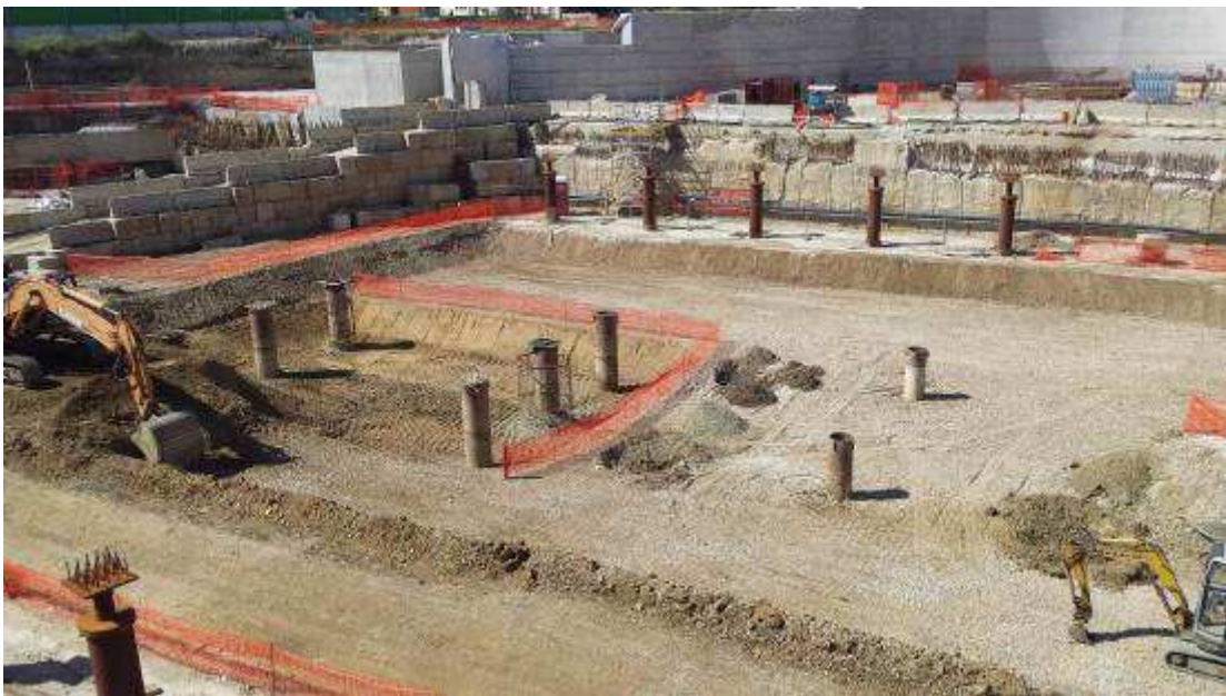
Foto 7 – Scavi per Montaggio Cassone Asse 33
