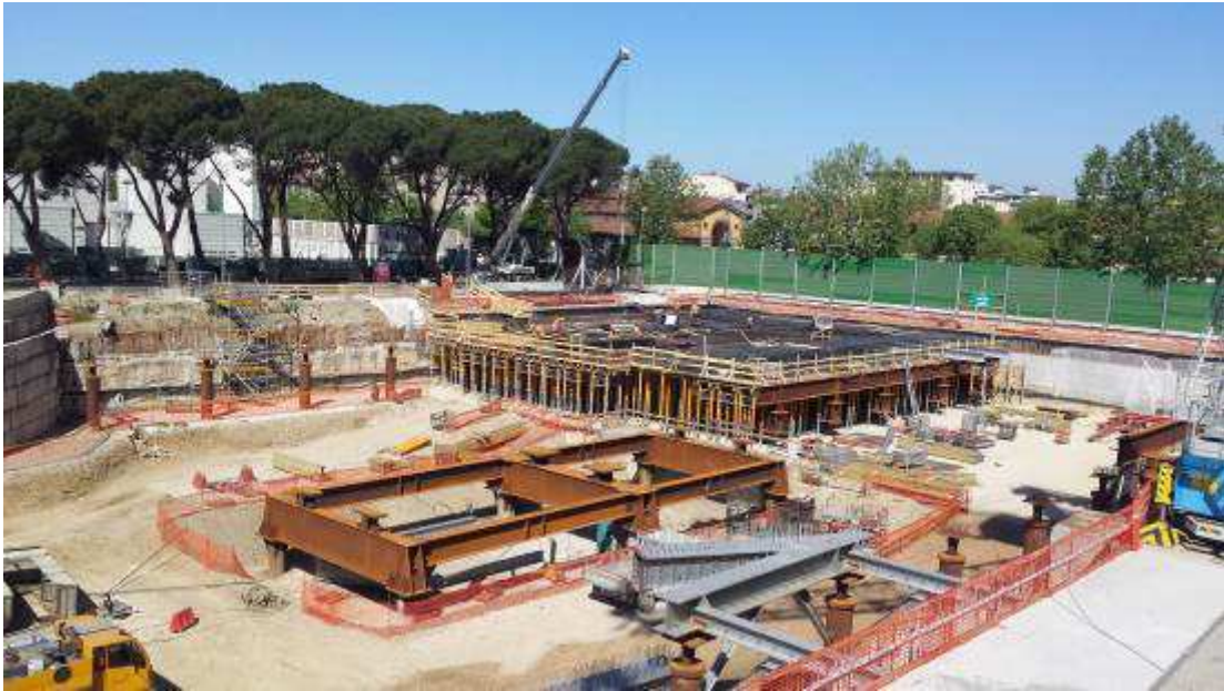
Foto 2 – Lavorazioni Testata Nord – Filo 1-3
