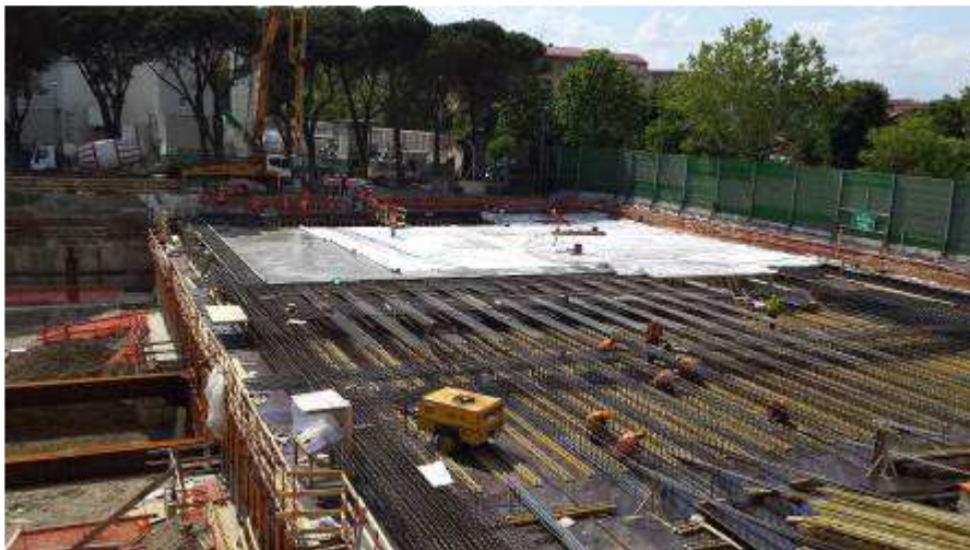
Foto 1 – Lavorazioni Testata Nord – Filo 1-3
