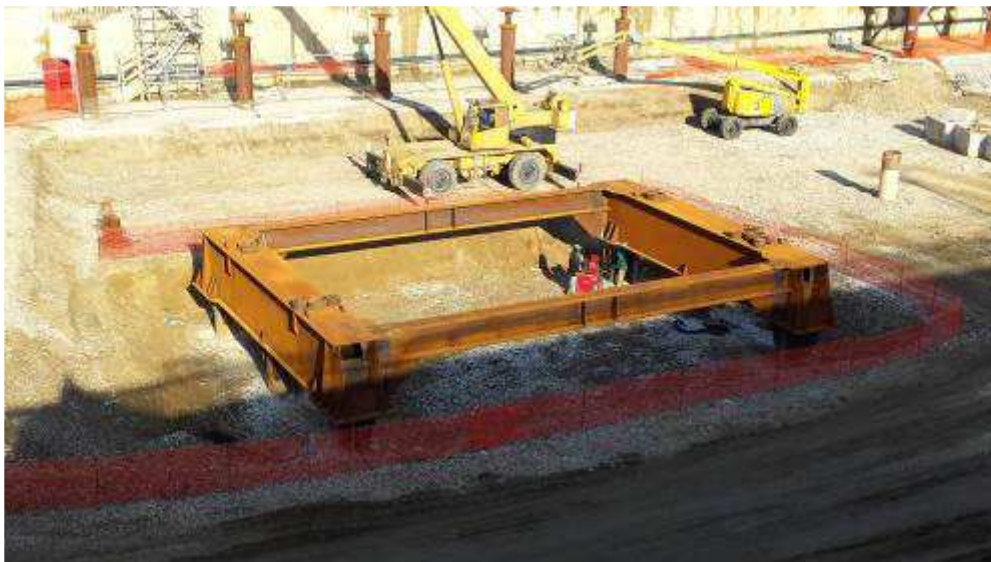
Foto 7 – Montaggio Travoni TP per appoggio Cassone Asse 33
