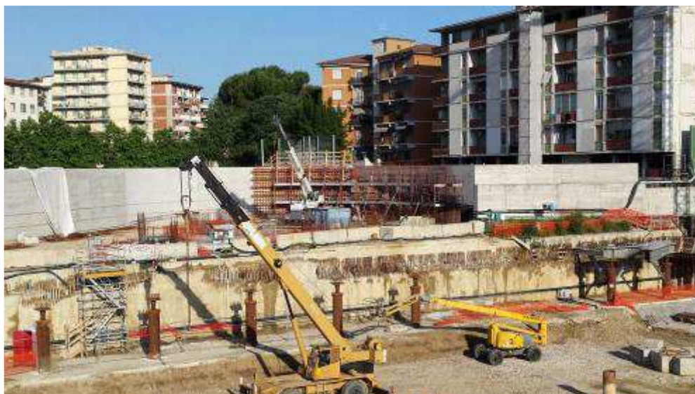
Foto 7 – Montaggio Travoni TP per appoggio Cassone Asse 33
