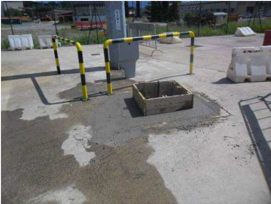
Foto 1 – Interventi per la Risoluzione della NC250 – Sostituzione chiusini Terminal
