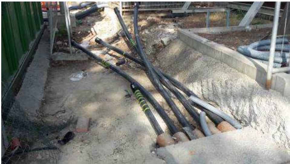
Foto 17 – Attività relative ai pozzi di continuità di falda – posa tubazioni
