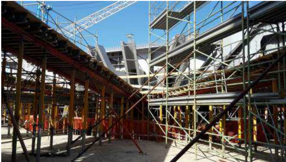
Foto 13 – Banchinaggio Travi intermedie e corte Ventaglio asse 25
