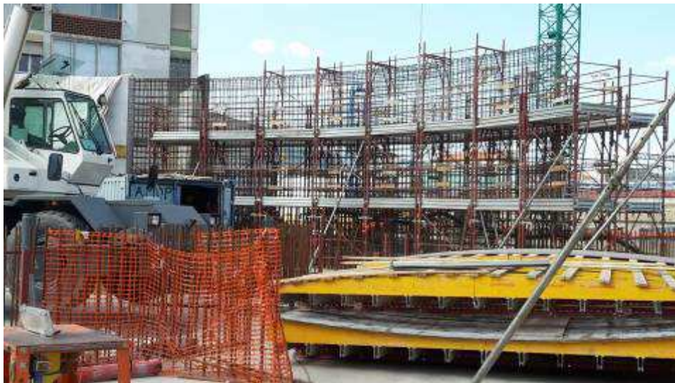
Foto 14 – Montaggio Armatura Rampa Kiss & Ride
