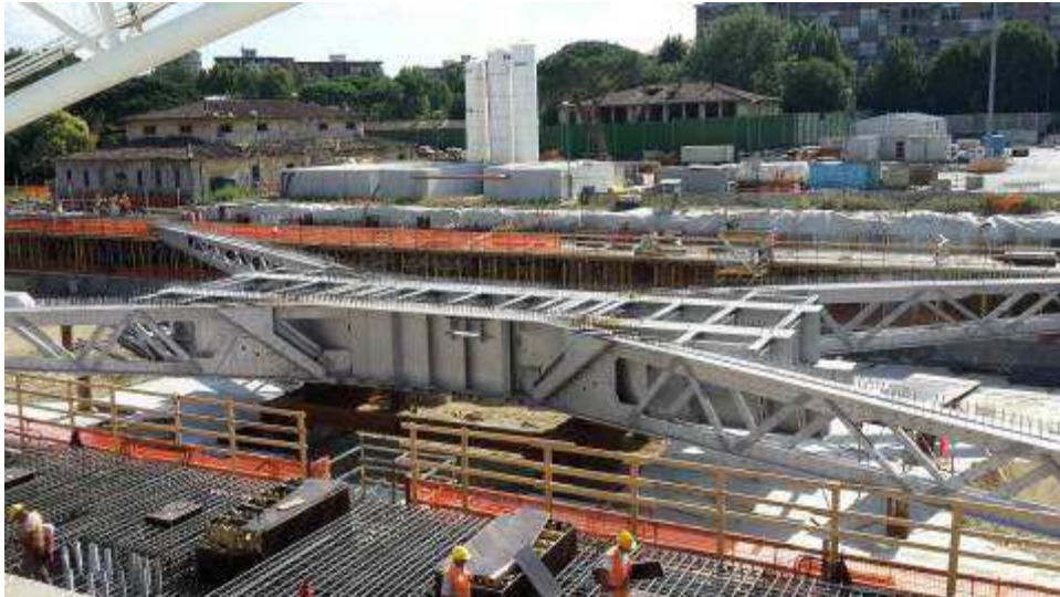
Foto 4 – Carpenterie metalliche Solaio Piano Terra – Ventaglio asse 9 e Banchinaggio Trave cuscino Fili 5-13 lato Ovest
