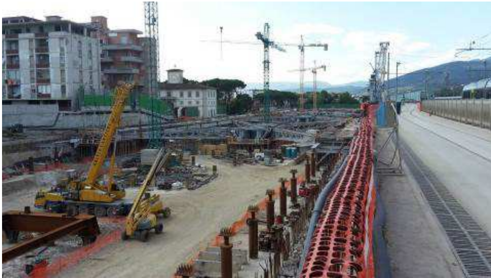
Foto 10 – Panoramica da Sud
