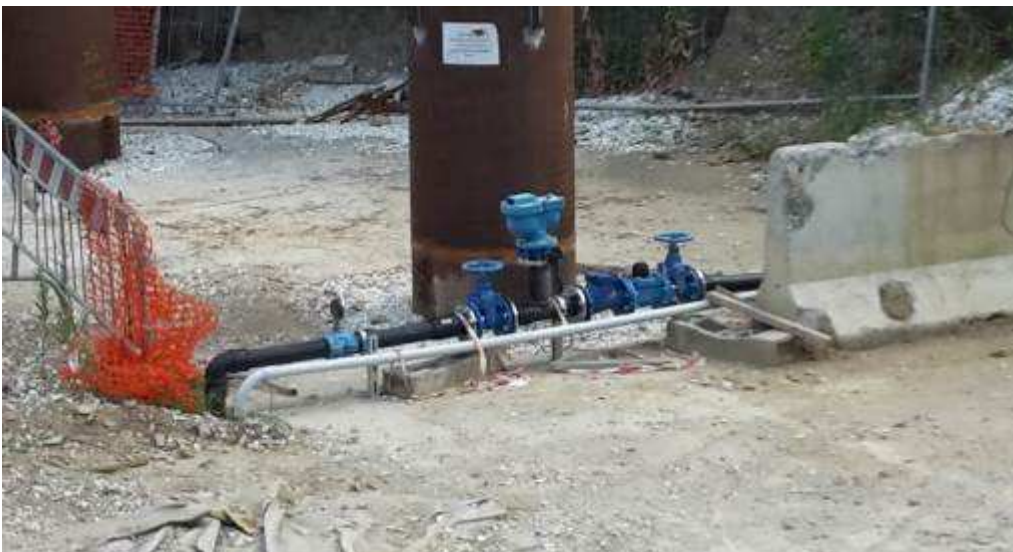
Foto 15 – Attività relative ai pozzi di continuità di falda – posa tubazioni e pezzi speciali
