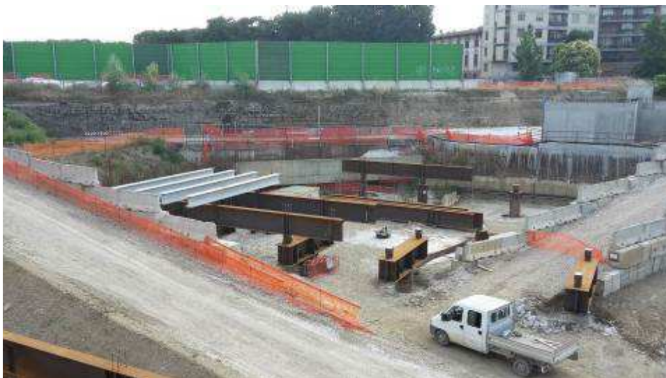
Foto 9 – Montaggio Strutture provvisorie Testata Sud
