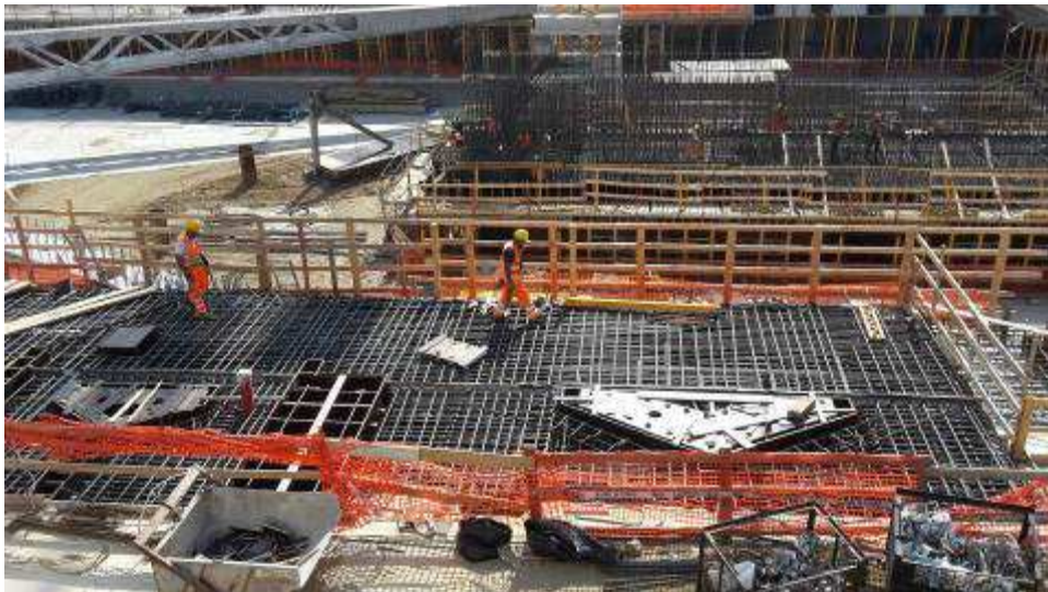
Foto 2 – Banchinaggio e montaggio armatura Trave cuscino Fili 5-13 lato Est
