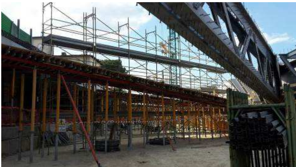
Foto 12 – Banchinaggio Travi intermedie e corte Ventaglio asse 25
