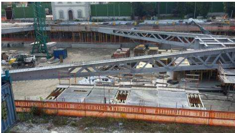
Foto 6 – Banchinaggio Trave cuscino Fili 13-21 lato Est ed Ovest
