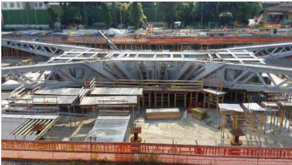
Foto 5 – Montaggio zone di collegamento tra le travi intermedie e corte e il cassone Asse 17 e Banchinaggio fondo cassone Ventaglio asse 17
