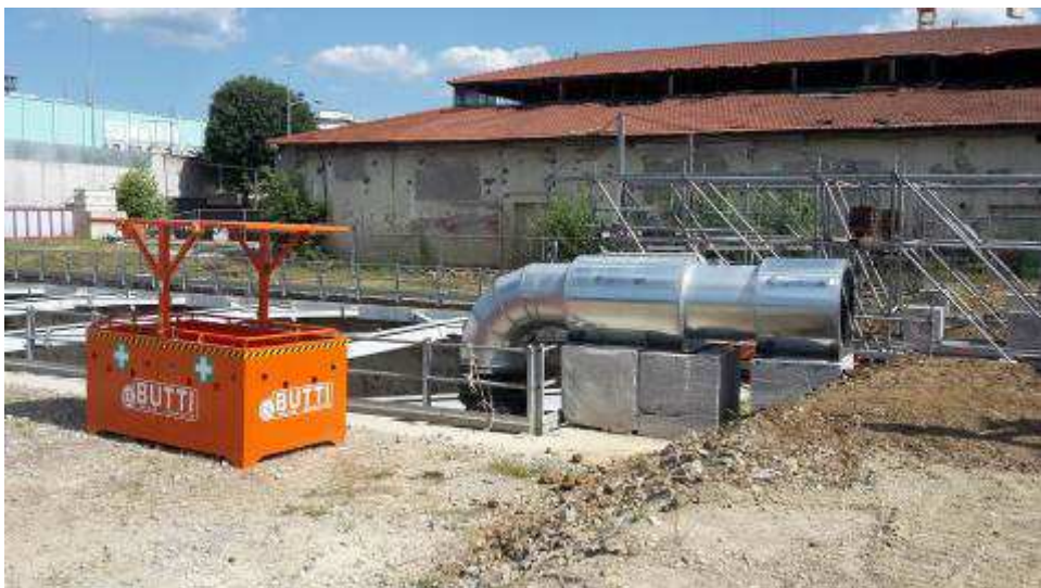
Foto 18 – Pozzo Nord - Montaggio Ventolino
