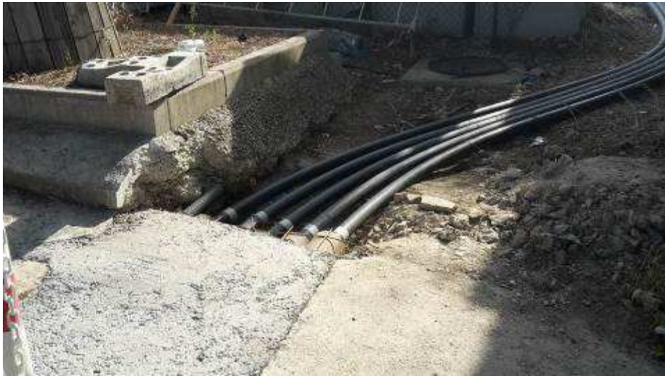
Foto 16 – Attività relative ai pozzi di continuità di falda – posa tubazioni
