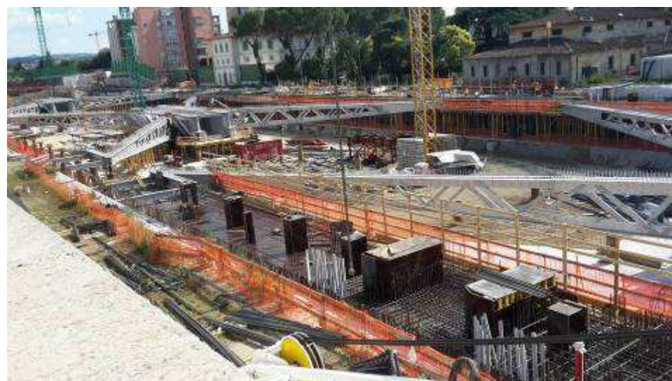
Foto 3 – Banchinaggio e montaggio armatura Trave cuscino Fili 5-13 lato Est ed Ovest
