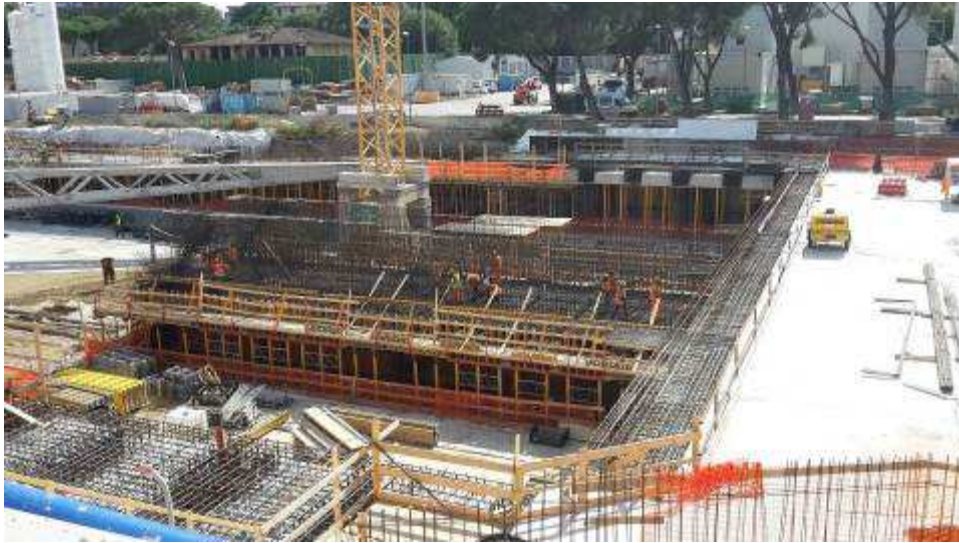
Foto 1 – Banchinaggio e montaggio armatura Cassone centrale Fili 4-5
