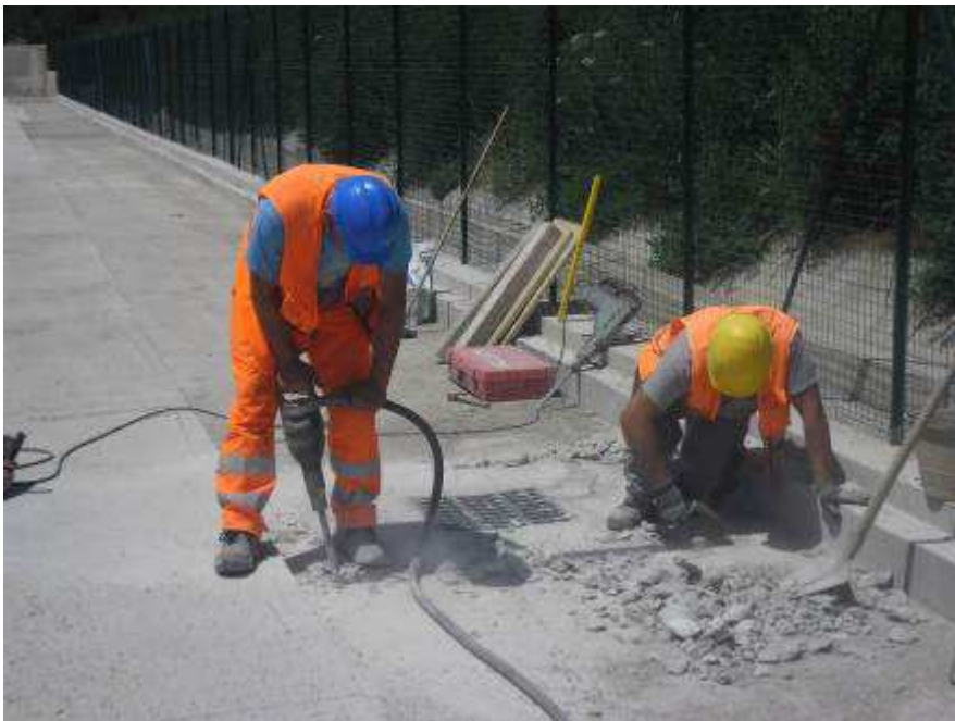
Foto 2 – Interventi per la Risoluzione della NC250 – Sostituzione chiusini Terminal
