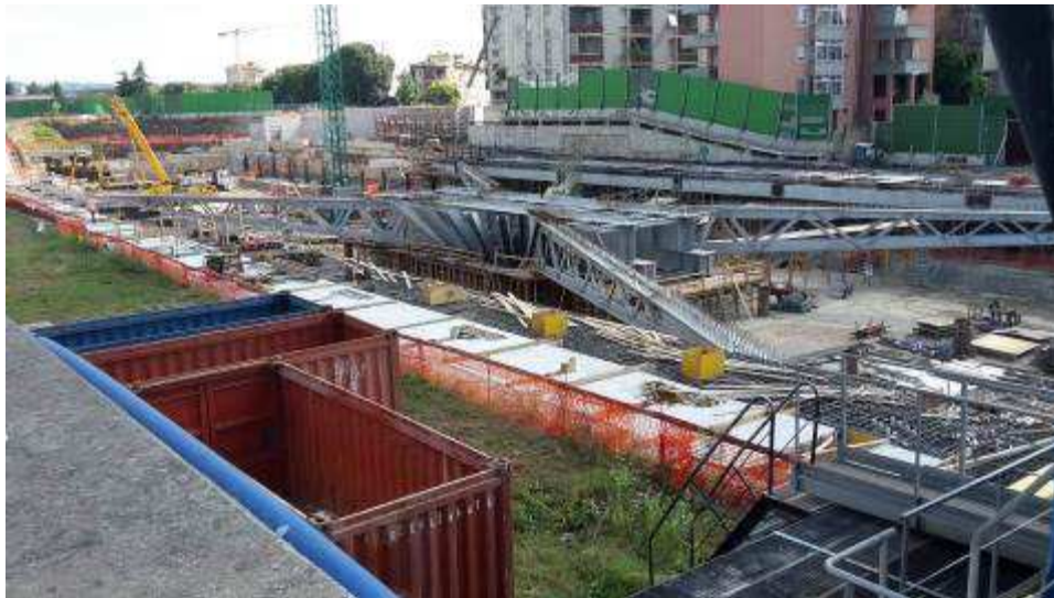
Foto 7 – Montaggio zone di collegamento tra le travi intermedie e corte e il cassone Asse 25
