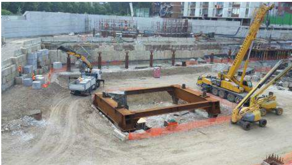
Foto 8 – Montaggio Travoni TP per appoggio Cassone Asse 33
